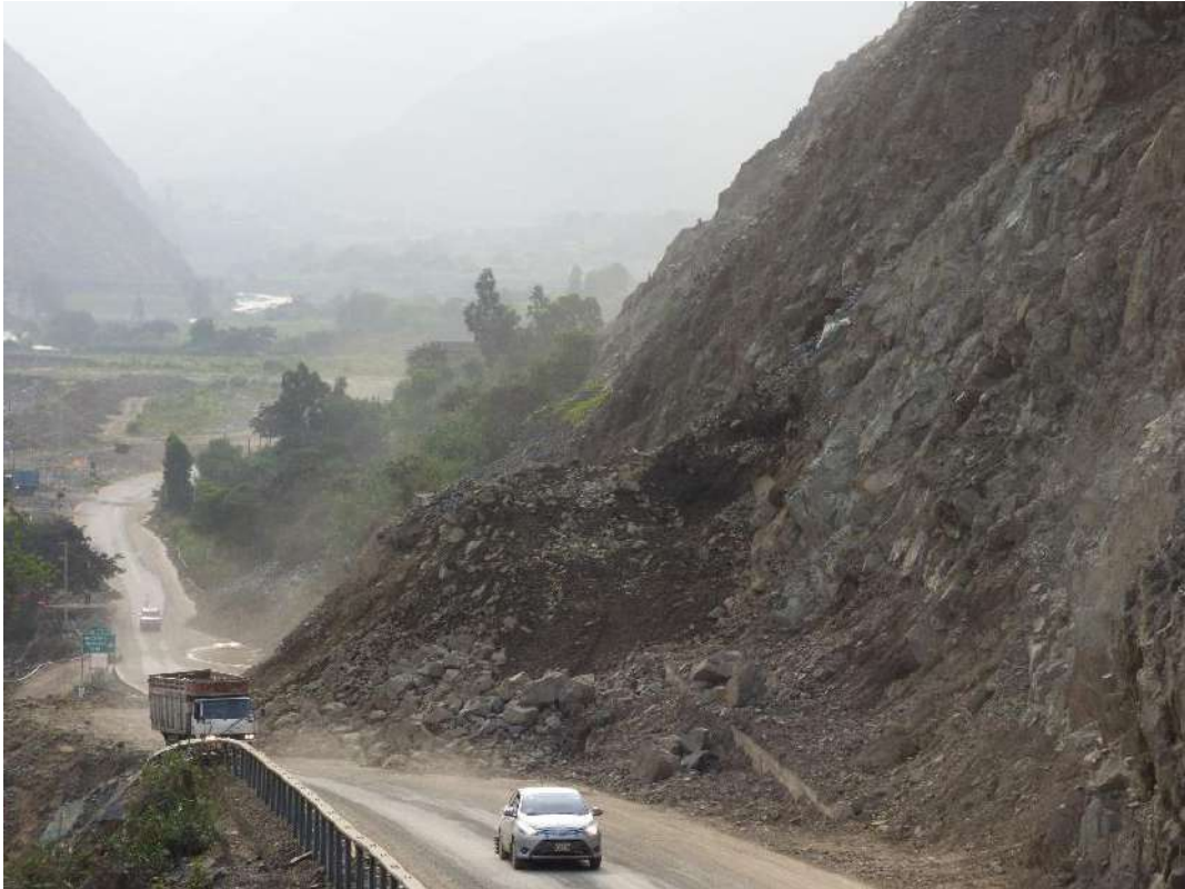
Foto 41. Carretera asfaltada Lima – Canta Km 51+000, afectado por derrumbe (6C-176).
