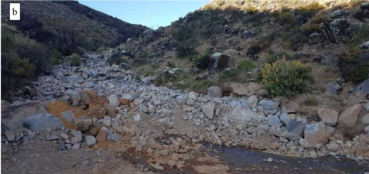
Foto 23. Inundación fluvial en el sector Tauripampa (6B-114). (a, b) Arrastre de bloques angulosos y subangulosos que afecto socavando el canal y causando daños en la carretera.
