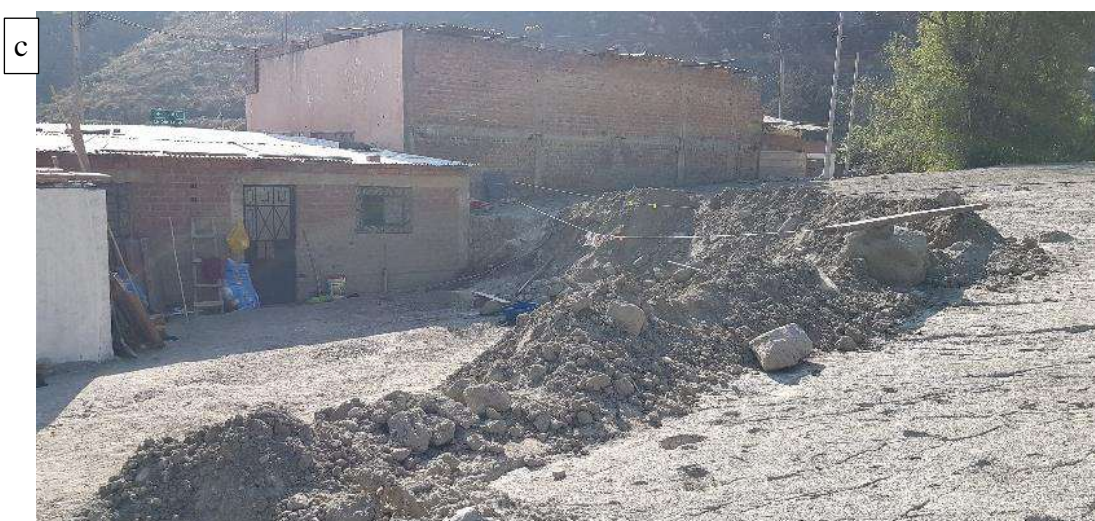
Foto 20. Flujo de lodo en el sector Santa Rosa, Pucshcama, (6B-007). (a) Depósitos de lodo que alcanzaron los 1.5 metros de altura. (b) Cubrieron el canal. (c) Cubrieron viviendas hasta 1.60 metros.
