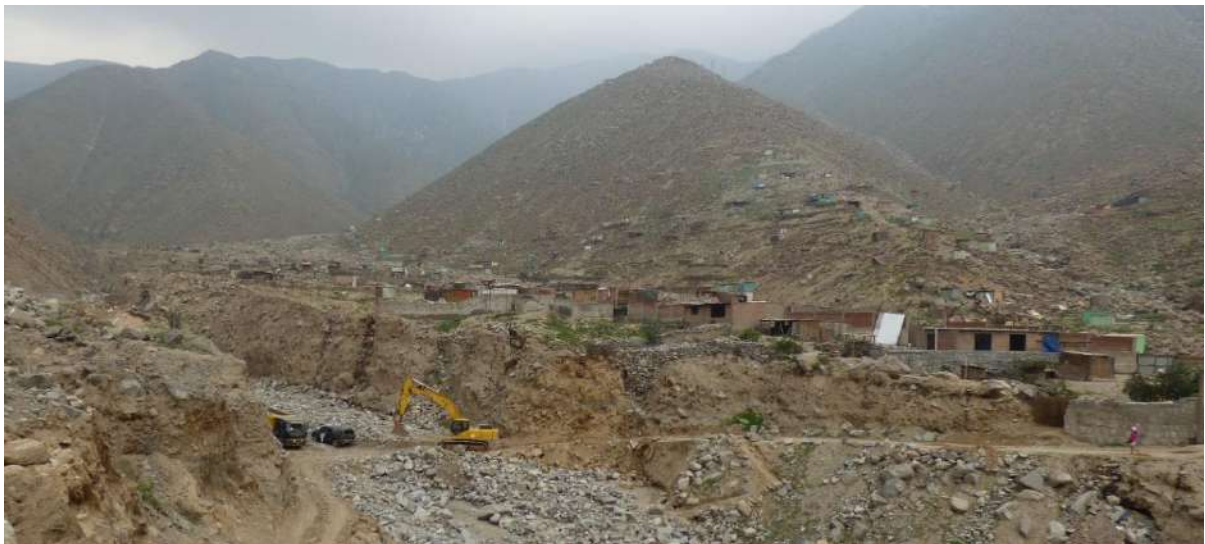
Foto 34. Parte alta de la Quebrada Quirio, sector La Esperanza, afectado por flujos de detritos. (Huarochirí). (6C-013)
