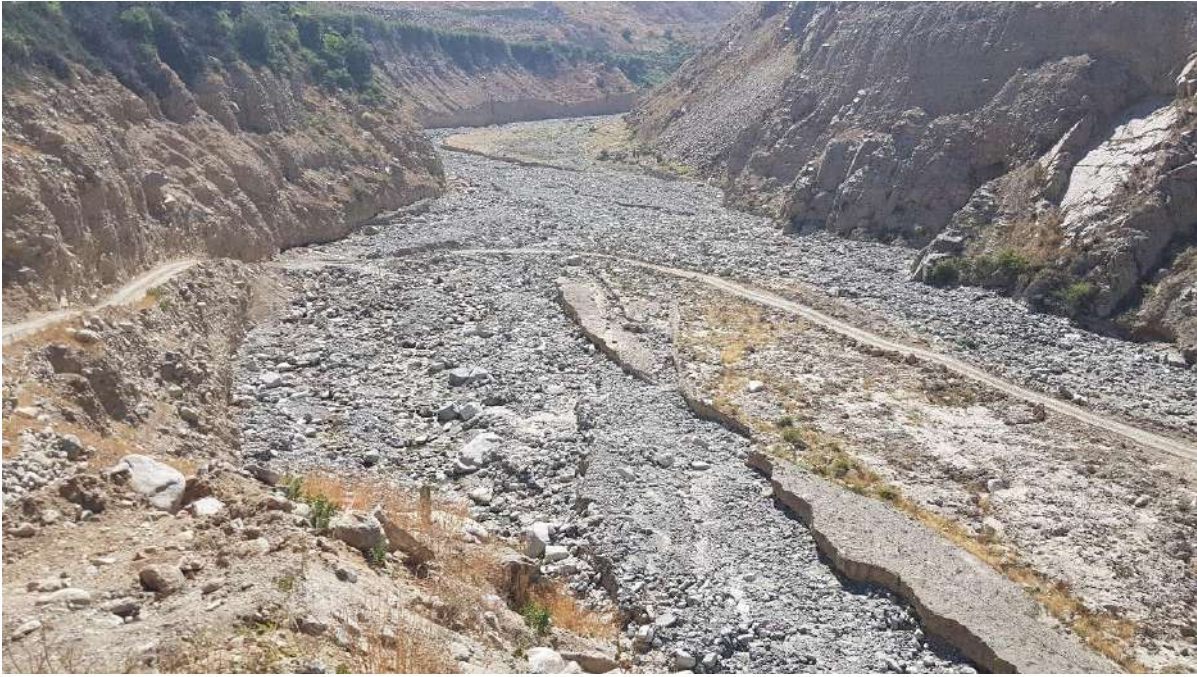
Foto 9. Flujo de rocas y lodo que cortan tramo de carretera Mala-Viscas sector Coñe (GB-049)
