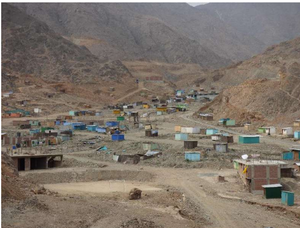
Foto 37. Asociación de propietarios Villa Jicamarca (cerro Media Luna), afectado por flujo de detritos canalizado, se observa que las viviendas están situadas en la quebrada seca (6C-153).
