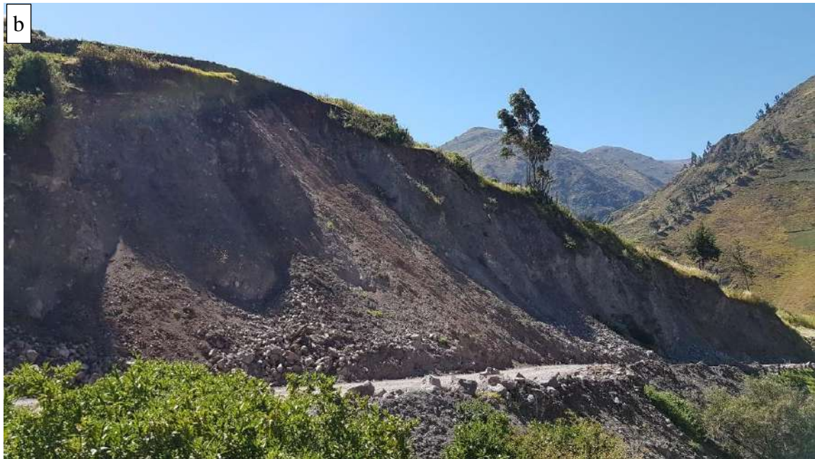
Foto 26. Derrumbes en el sector San Damián, (6B-013). (a) Se activaron diferentes derrumbes. (b) Los derrumbes cubrieron canales de riego en longitudes de hasta 50 metros de largo.
