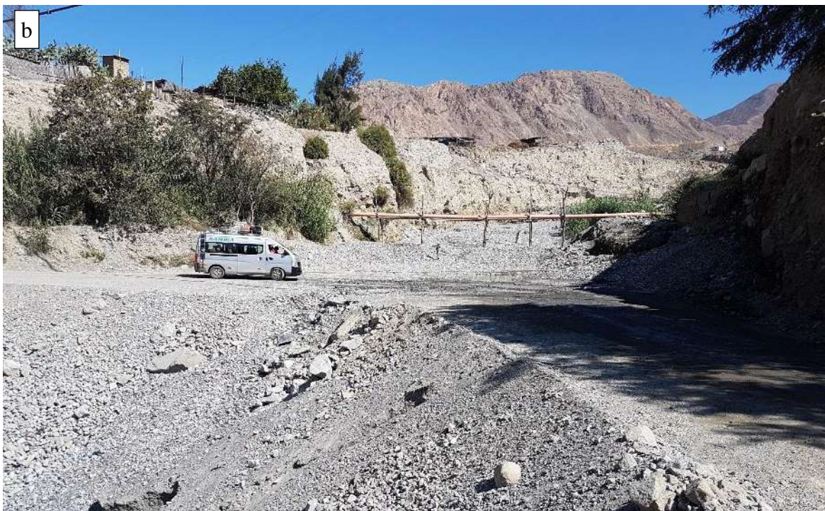
Foto 25. Flujo en el sector Machuranga (6B-077). (a) Los flujos alcanzaron depósitos de hasta 4.5 metros de altura. (b) Daños en las tuberías de agua, canal de riego y la carretera, actualmente se vienen rehabilitando.
