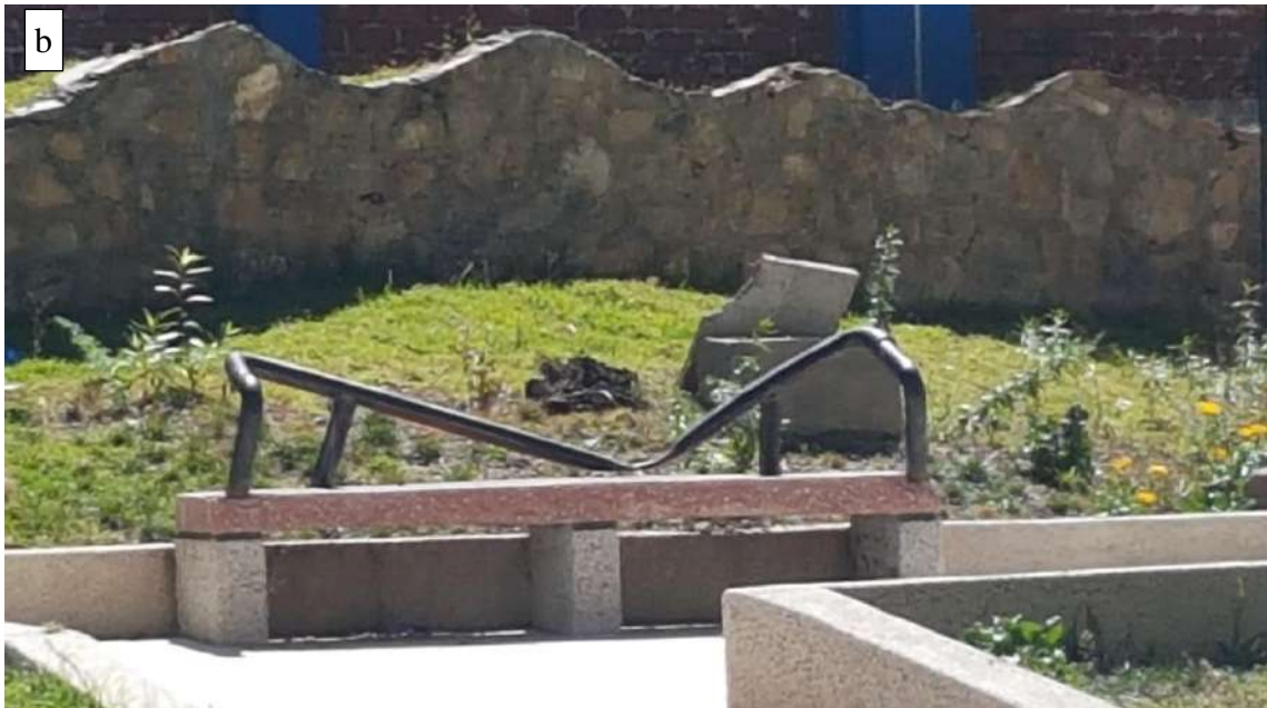
Foto 30. Derrumbes y caída de rocas en el sector Alis, (6B-163). (a) Caída de bloques de hasta 85 x 65 cm. (b) Daños en las infraestructuras del atractivo turístico del mirador del pueblo de Alis.
