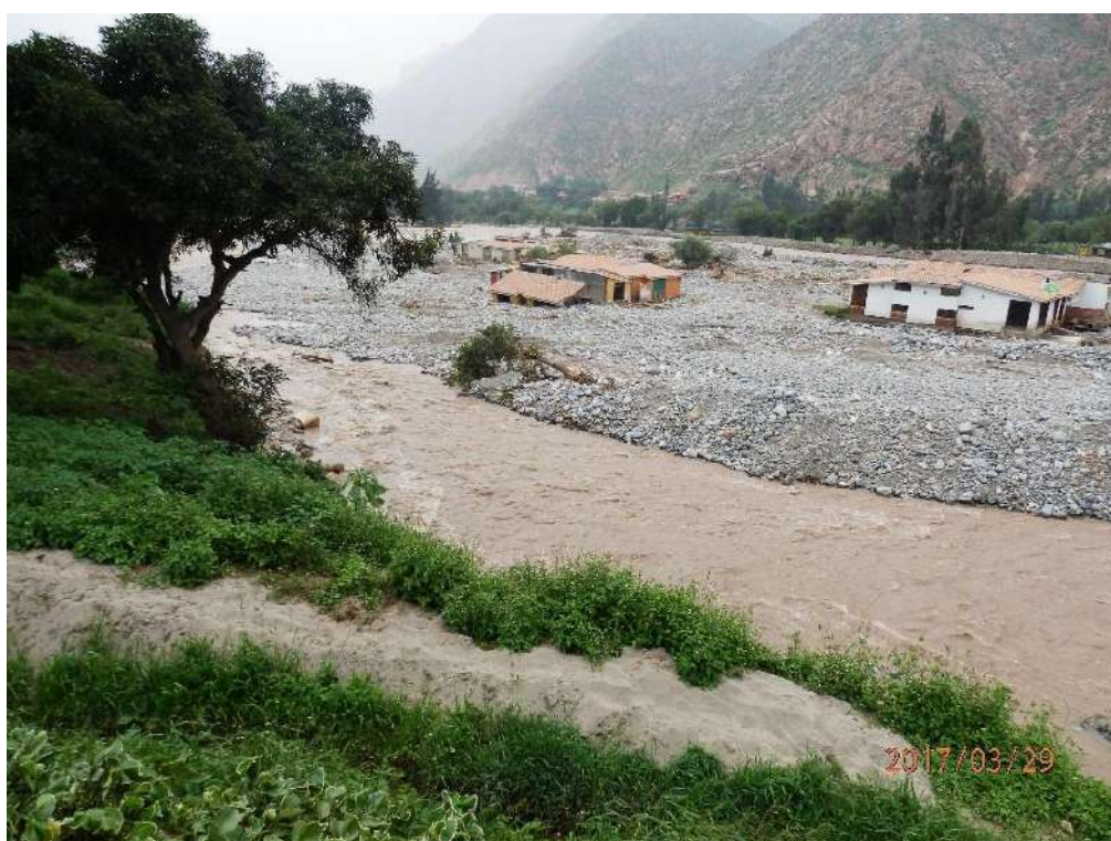
Foto 38. Centro recreacional Los Molles, afectado por inundación; se observa que las viviendas fueron cubiertas por material detrítico alcanzando hasta 0.5 m, dejando inhabitable (6C-167).
