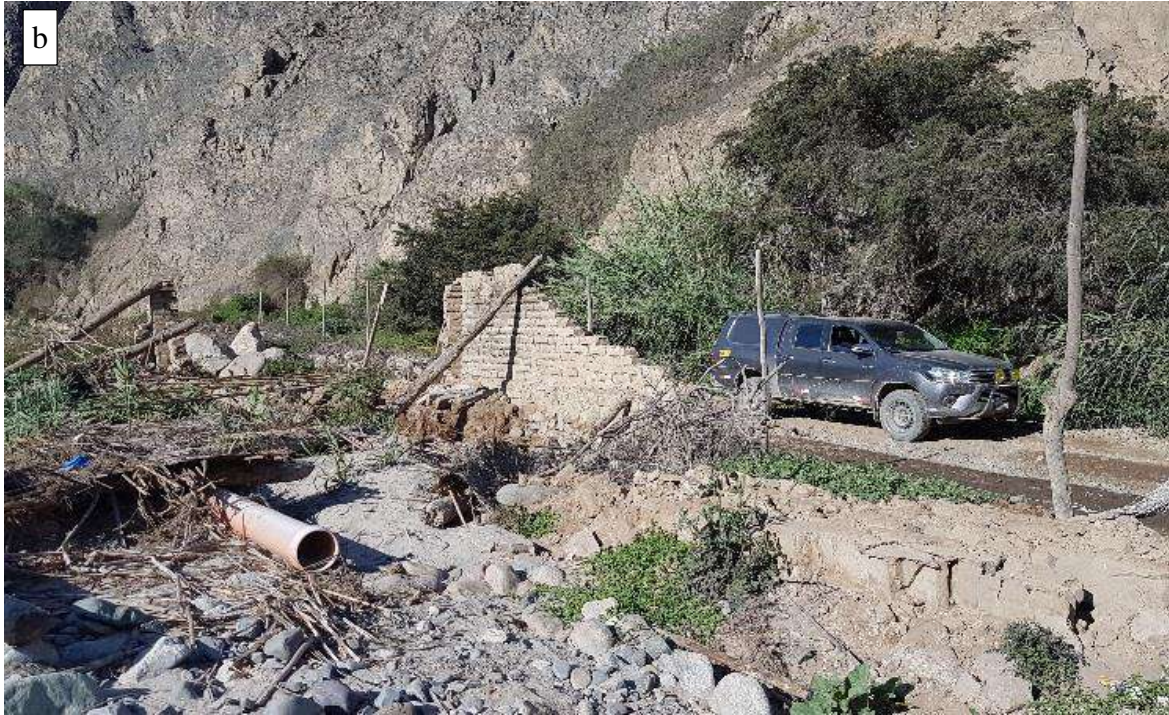
Foto 19. Inundación fluvial en el sector Huañañabe (6B-057). (a) Desborde del río Omas, afectando la carretera, áreas de cultivo, colmatando las bocatomas y el canal de riego. (b) Muros perimétricos caídos y red de alcantarillado inhabilitado, cubiertos de depósitos que removieron arbustos y malezas.
