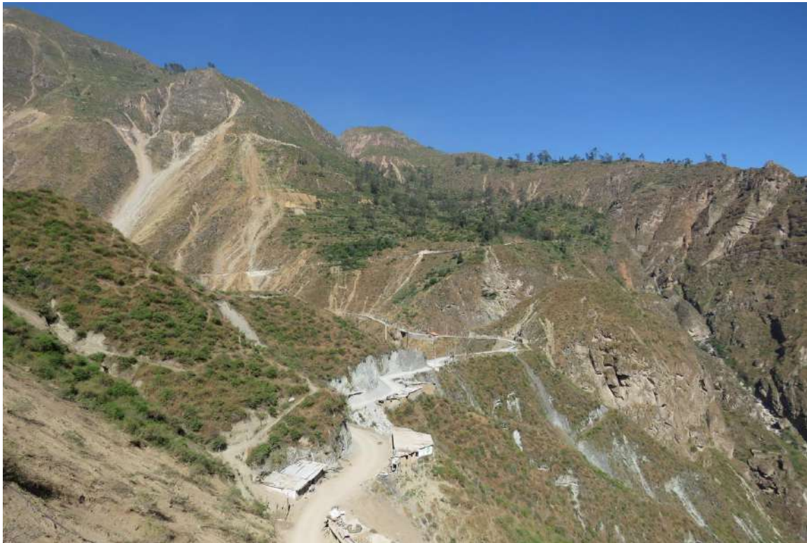
Foto 48. Trocha Callahuanca Chaclla (6A-026), carretera afectada por deslizamientos simultáneos.
