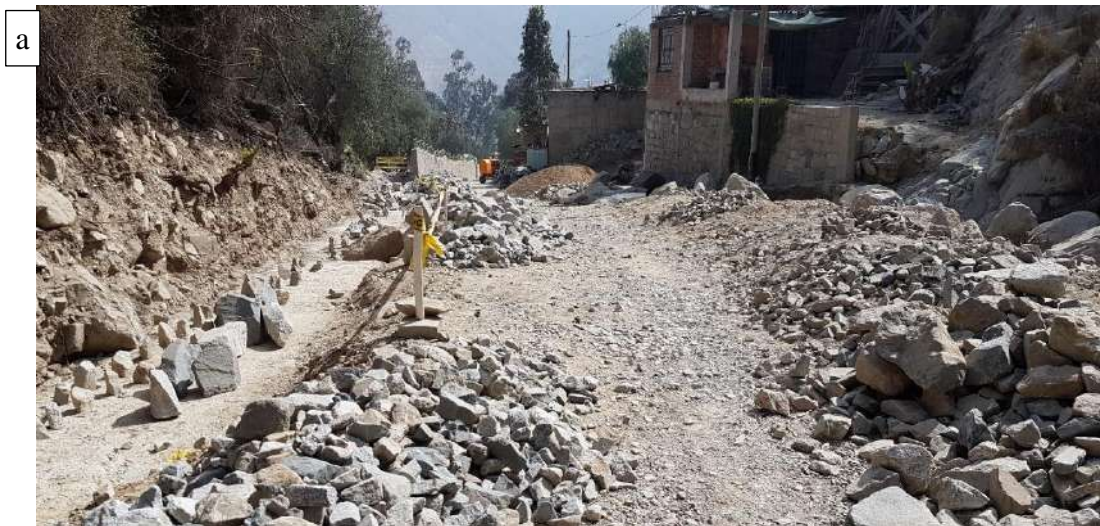
Foto 23. Inundación fluvial en el sector Tauripampa (6B-114). (a, b) Arrastre de bloques angulosos y subangulosos que afecto socavando el canal y causando daños en la carretera.
