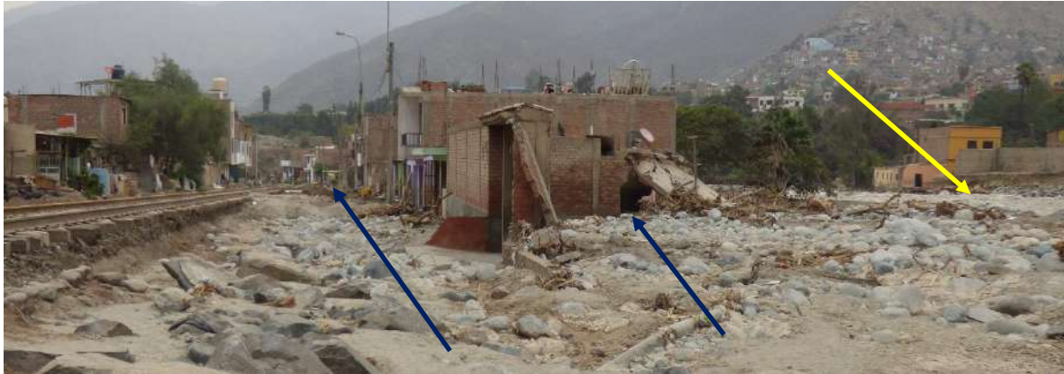
Foto 35. Sector Los Cañaverales en Chosica, afectado por inundación del río. Se muestra por donde se canalizó el río (líneas azules). La flecha amarilla indica el cauce del río (6C-051)
