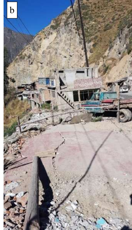
Foto 22. Derrumbe y asentamiento en el sector Daza (6B-009), (a) En la carretera central. (b, c) Grietas y amenaza a las casas que se encuentran en la carretera, debilitándolas para que se derrumben.
