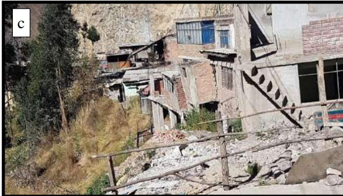
Foto 22. Derrumbe y asentamiento en el sector Daza (6B-009), (a) En la carretera central. (b, c) Grietas y amenaza a las casas que se encuentran en la carretera, debilitándolas para que se derrumben.
