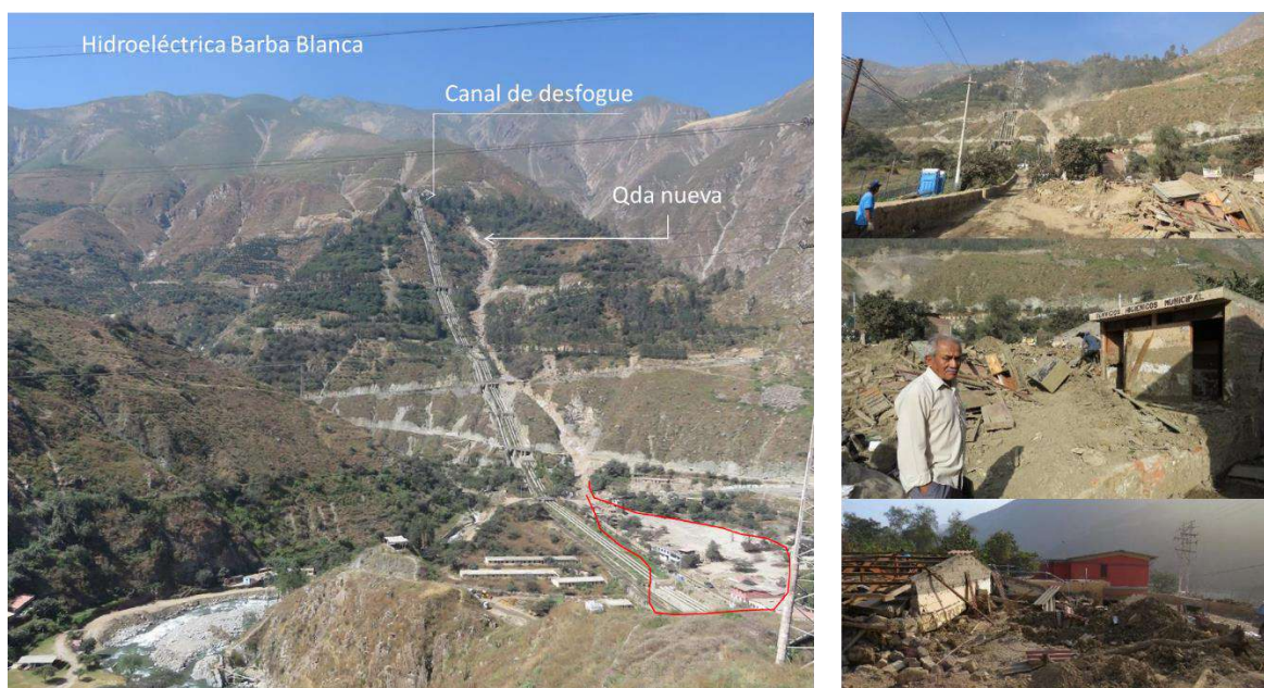
Foto 46. Barba Blanca (6A-041), comunidad que se vio afectada por huayco generado por el desborde del reservorio ubicado en la parte superior del cerro Barba blanca (imagen izq.) y 2 huaycos naturales procedentes del sur. Viéndose destruido casi la totalidad del centro poblado como Centro Educativo.
