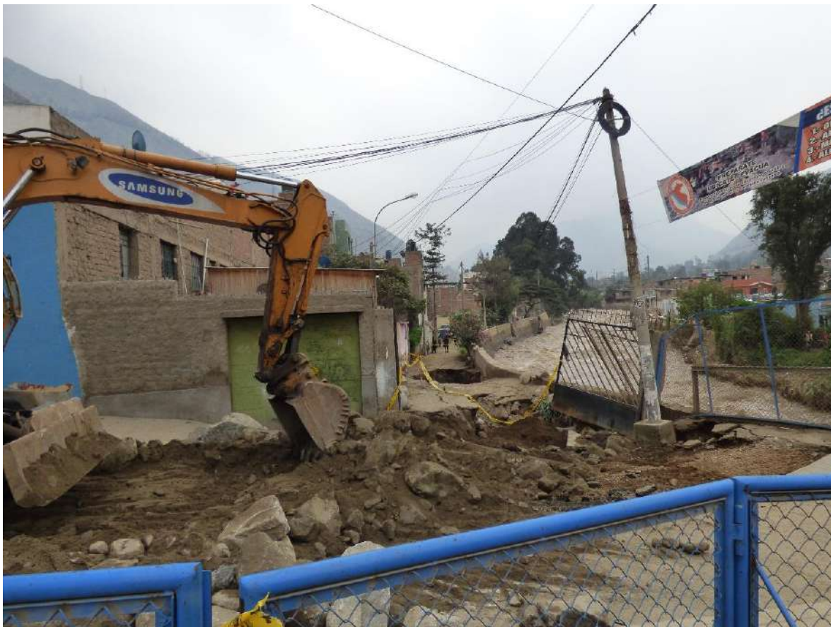
Foto 36. Viviendas del AH. Pro Cantagallo/La Florida, margen izquierda del río Rímac, afectadas por la erosión fluvial. (6C-256).
