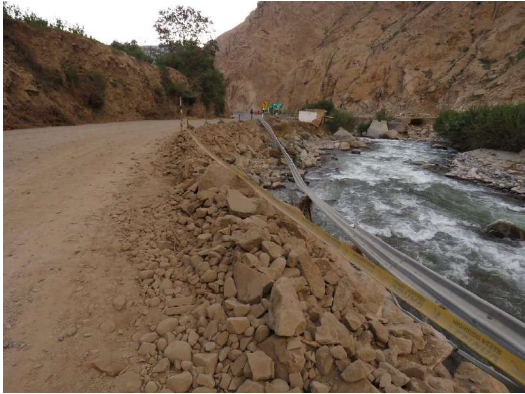
Foto 50. Carretera a Huayupampa (Sumbilca– Huaral): carretera afectada por la erosión de terraza baja, se comprometió el soporte metálico (6A-023).
