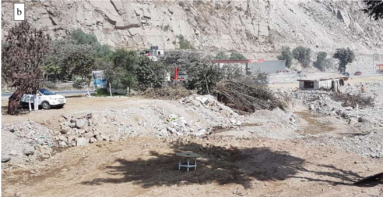
Foto 18. Inundación fluvial en el sector campestre Valle del Sol (6B-003). (a) Acción erosiva por desborde del río Rímac que afecta viviendas y áreas libres, colapso de alcantarillados (red de drenaje domiciliar) e inhabilitación de viviendas, (b) Viviendas e infraestructura de centro campestre dañados, que necesitan ser rehabilitadas.
