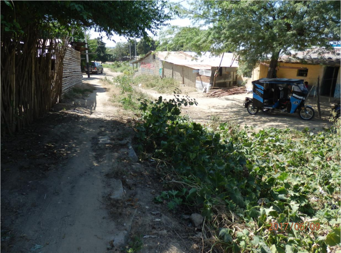
Foto 3. Afluente de la quebrada Luay, que es ocupada por viviendas sin respetar su cauce natural.
