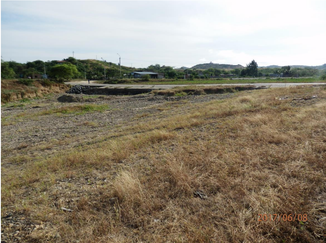
Foto 5. Quebrada La Jardina, flujo afecta Baden
