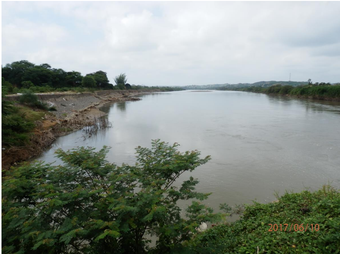
Foto 2. Margen izquierda del río Tumbes, sector Los Tamarindos, es afectado por la erosión fluvial.
