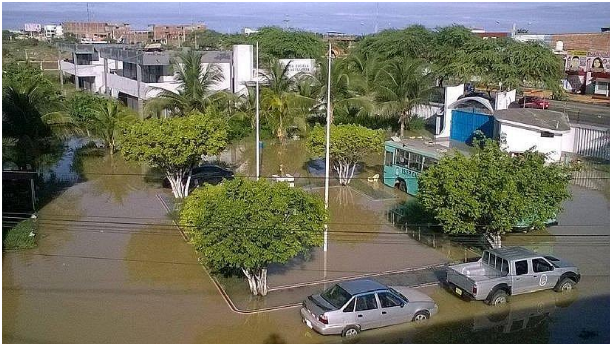
Foto 9. Calles de la ciudad de Tumbes después de las precipitaciones pluviales, inundación afecta las partes bajas.
