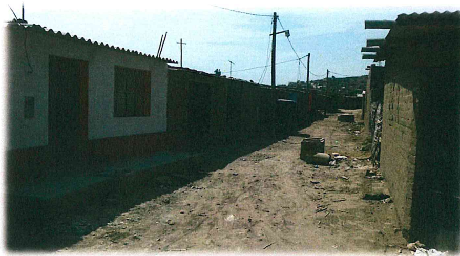
Foto N° 3: Viviendas con techos de plancha de calamina
