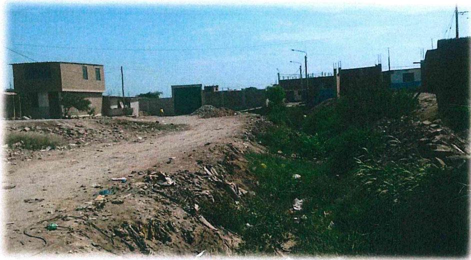
Foto N° 19: Vista de drenes (Acequias) colmatadas con presencia de vegetación
