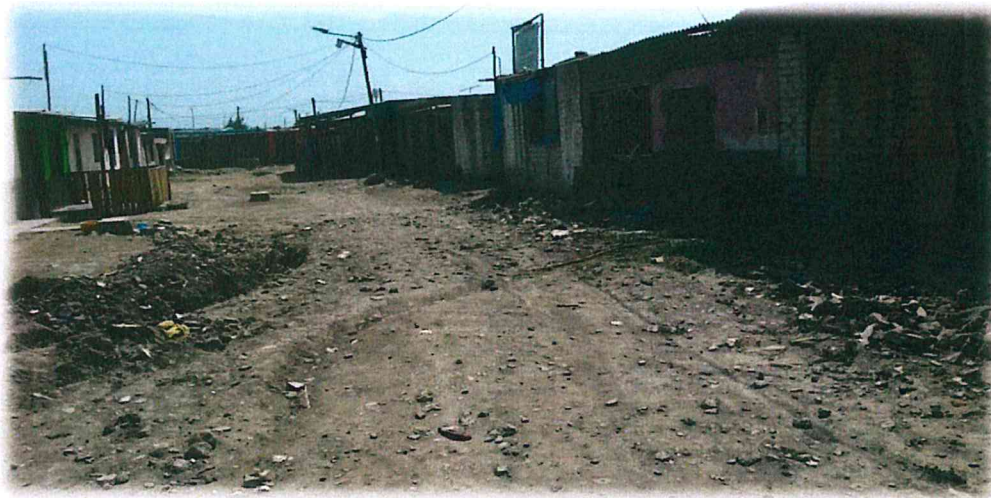
Foto N° 16, 17 y 18: Predomina Vías locales sin pistas ni veredas.
