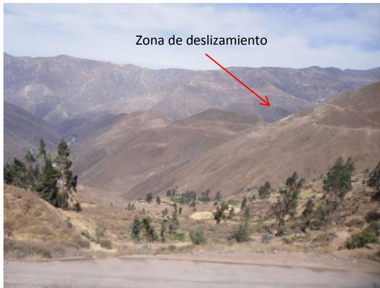
Foto 6: Vista panorámica de la zona de deslizamiento, donde se observa la pendiente general de la ladera (30°).
