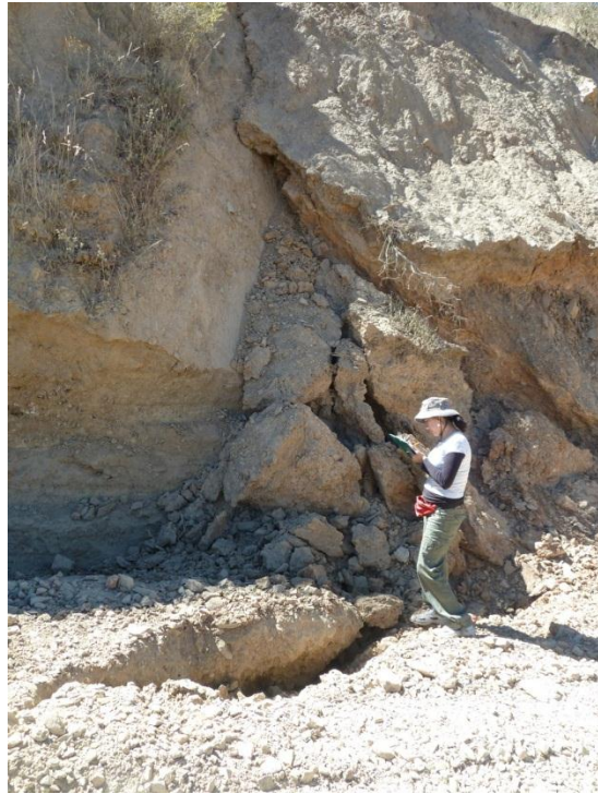
Fotos 4 y 5: Vistas donde es posible observar el plano del deslizamiento traslacional, cortando el talud superior de corte de carretera. (29 de junio de 2011)
