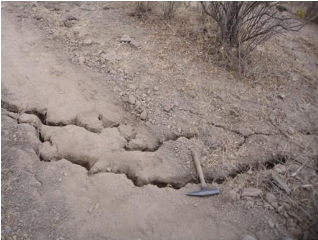
Foto 14: Detalle de las grietas abiertas ubicadas encima de la corona del deslizamiento.
