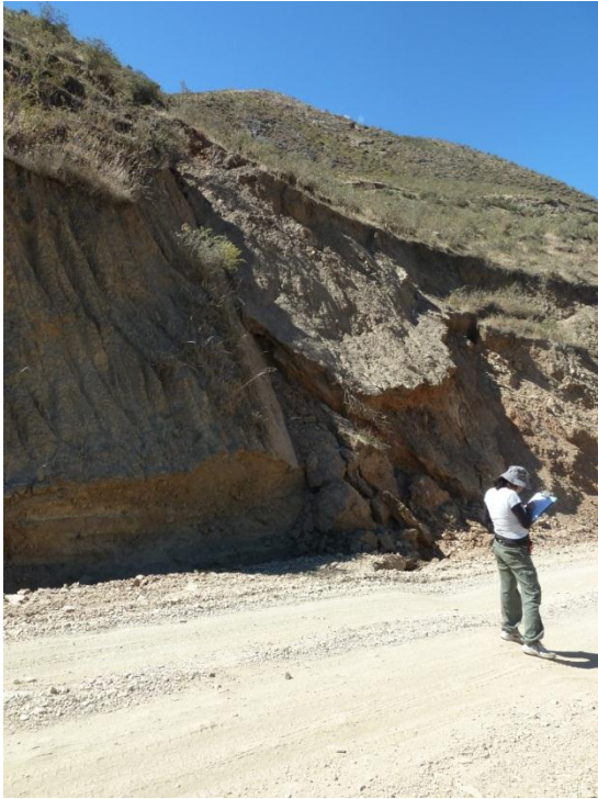
Fotos 4 y 5: Vistas donde es posible observar el plano del deslizamiento traslacional, cortando el talud superior de corte de carretera. (29 de junio de 2011)
