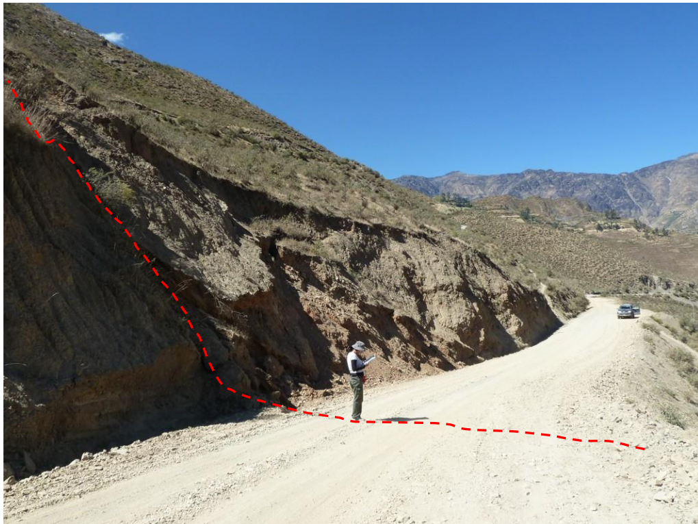
Foto 3: Se señala con línea roja el plano del deslizamiento manifestado en la ladera, plataforma y el talud de corte de carretera. (29 de junio de 2011)
