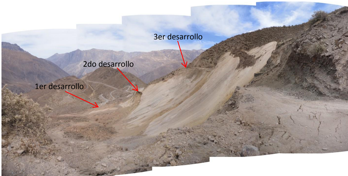
Foto 11 Vista desde el flanco izquierdo del deslizamiento, donde se puede observar la escarpa del deslizamiento, su ángulo de inclinación y el control litológico existente. Con flechas rojas se señala la ubicación de los desarrollos de carretera destruidos.
