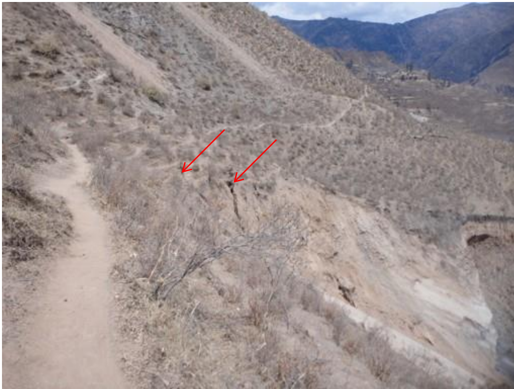
Foto 13: Se señala con la flecha roja la presencia de grietas abiertas por detrás de la corona de deslizamiento.
