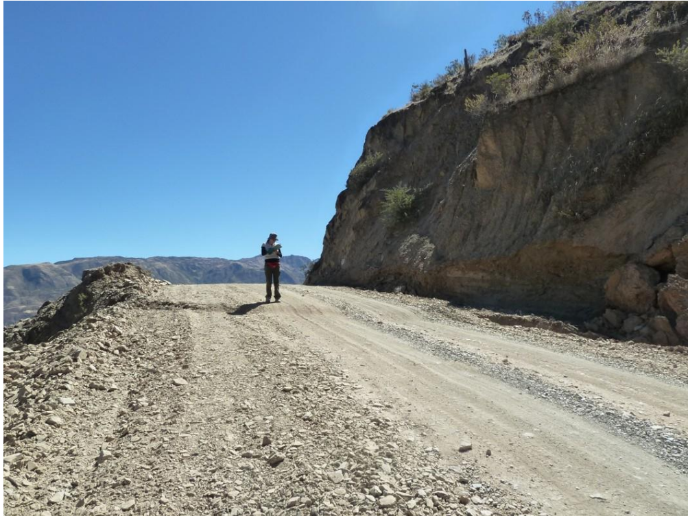
Fotos 2: Vista de la plataforma de carretera, donde es posible observar los asentamientos producidos por el deslizamiento. (29 de junio de 2011)
