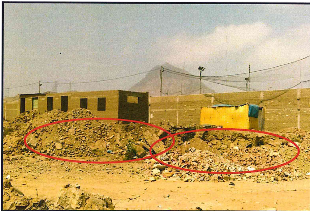
Fotografía N° 2: Existencia de material de relleno, residuos sólidos y desmonte en el cauce de la Quebrada Leon
