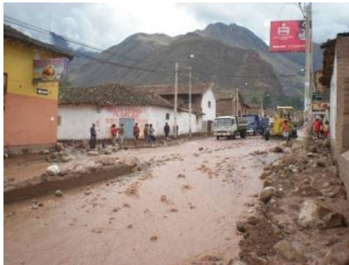
Foto 46: Rastros de flujo de detritos en la parte baja de la Av. Mariscal Castilla.
