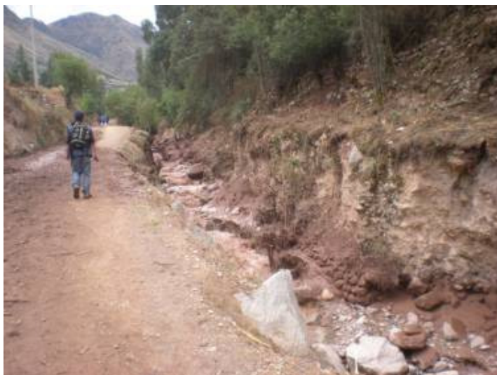
Foto 42: Tramo de la quebrada Chicón donde el flujo aluviónico se canalizó.
