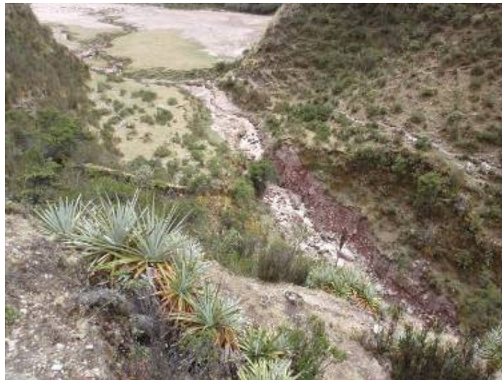
Foto 23: Márgenes del río Occororuyoc erosionados por el nuevo flujo aluviónico que se va creando en este sector
