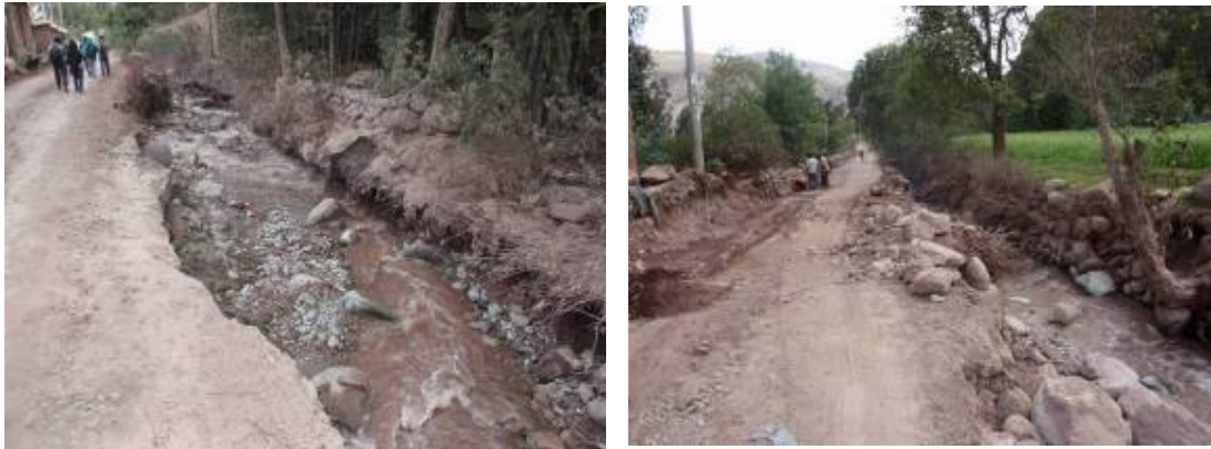
Fotos 35 y 36: Estrechamiento del canal del río (izquierda) y de la canalización inca (derecha) por ampliación de la carretera- En ambos casos hay erosión y desborde de flujo de detritos (aluvión del 17 de Octubre del 2010).
