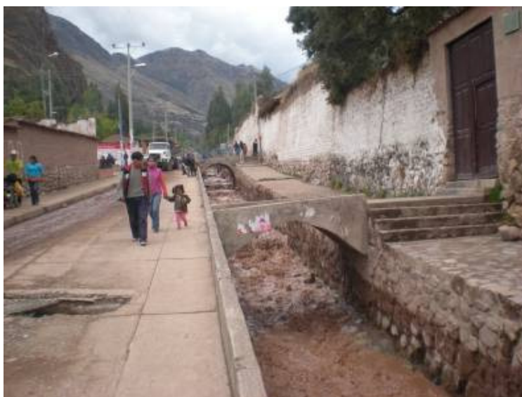
Foto 44: Material aluviónico se canalizó y pasó en el tramo del cementerio.
