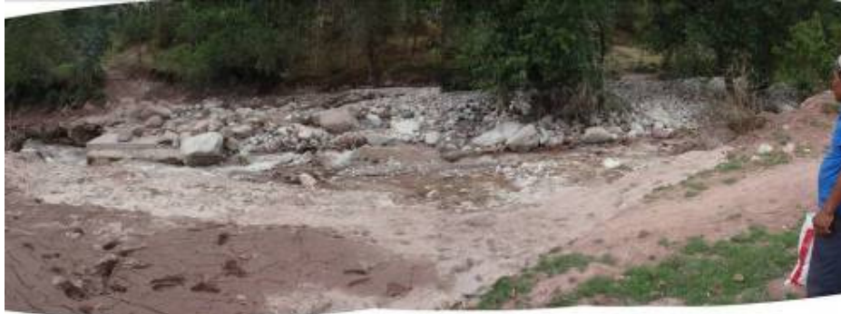
Foto 32: Puente destruido (extremo izquierdo de la foto), con relleno de flujo de detritos, mostrando además desborde de flujo de lodo y aguas abajo con huellas de erosión.
