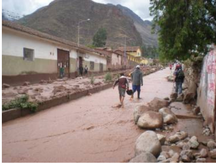
Foto 45: Canalización de la Av. Mariscal Castilla completamente colmatado por retroceso.
