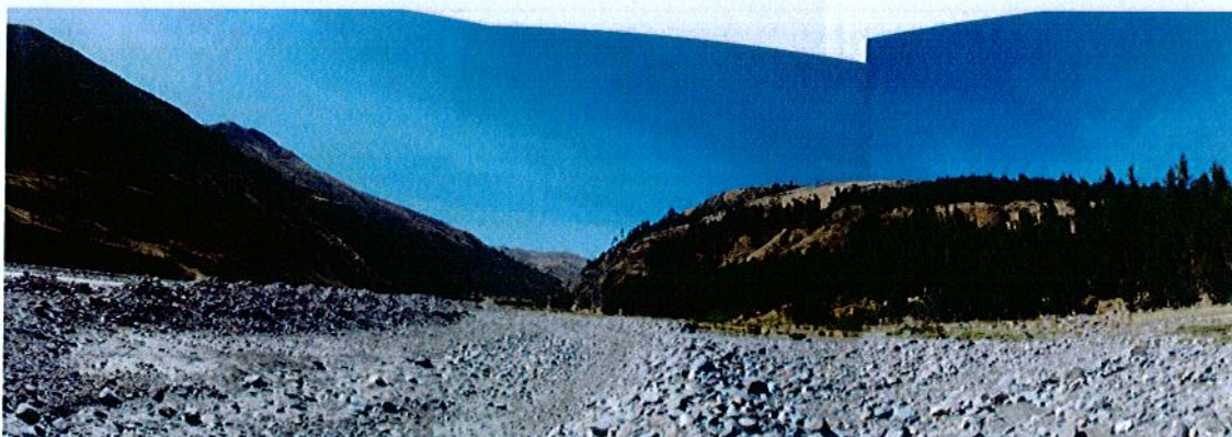
Foto 5: Vista aguas arriba del río Mapacho es posible ver las defensas rivereñas colocadas en una longitud de aproximadamente 750 m.
