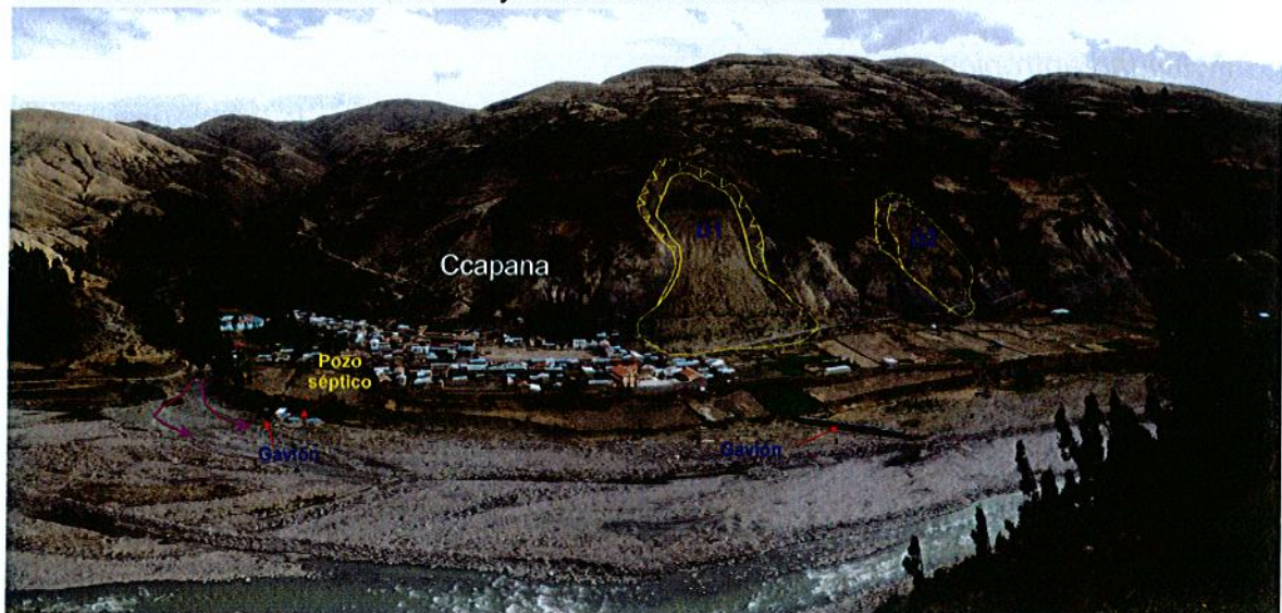
Foto 22: Vista Panorámica donde es posible observar los deslizamientos D1 y D2, el poblado de Ccapana, el huayco que baja de la quebrada Marcohuayjo y las defensas rivereñas (gaviones) colocados en la margen izquierda del río Mapocho.
