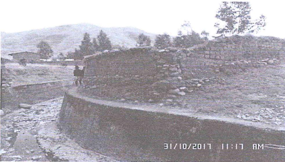
Fotografía 04: Donde se aprecia la invasión de viviendas hasta el muro de contención sin respetar el ancho mínimo de la faja marginal.
