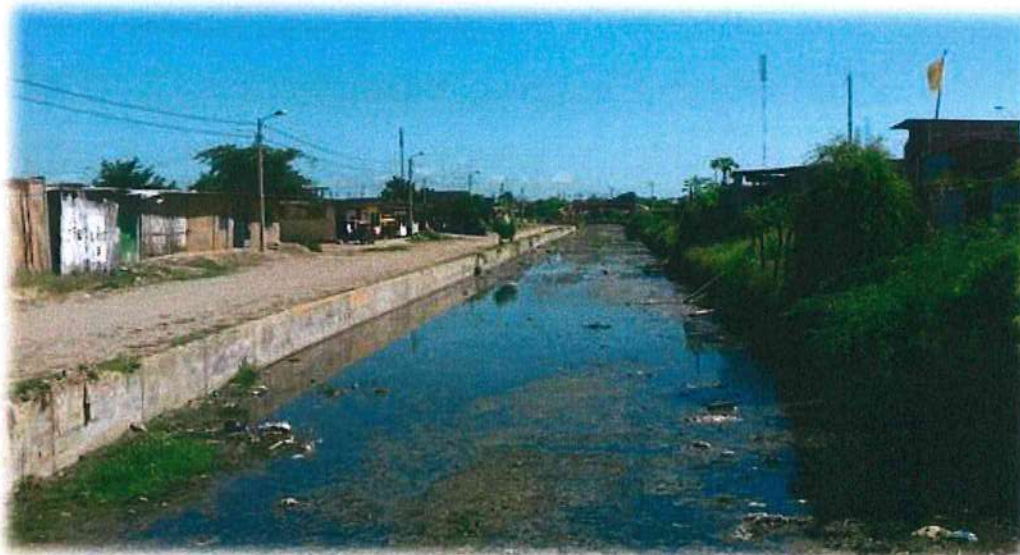
Foto N° 18, 19, 20: Canal Vía – Avenida Tarapacá Tumbes
