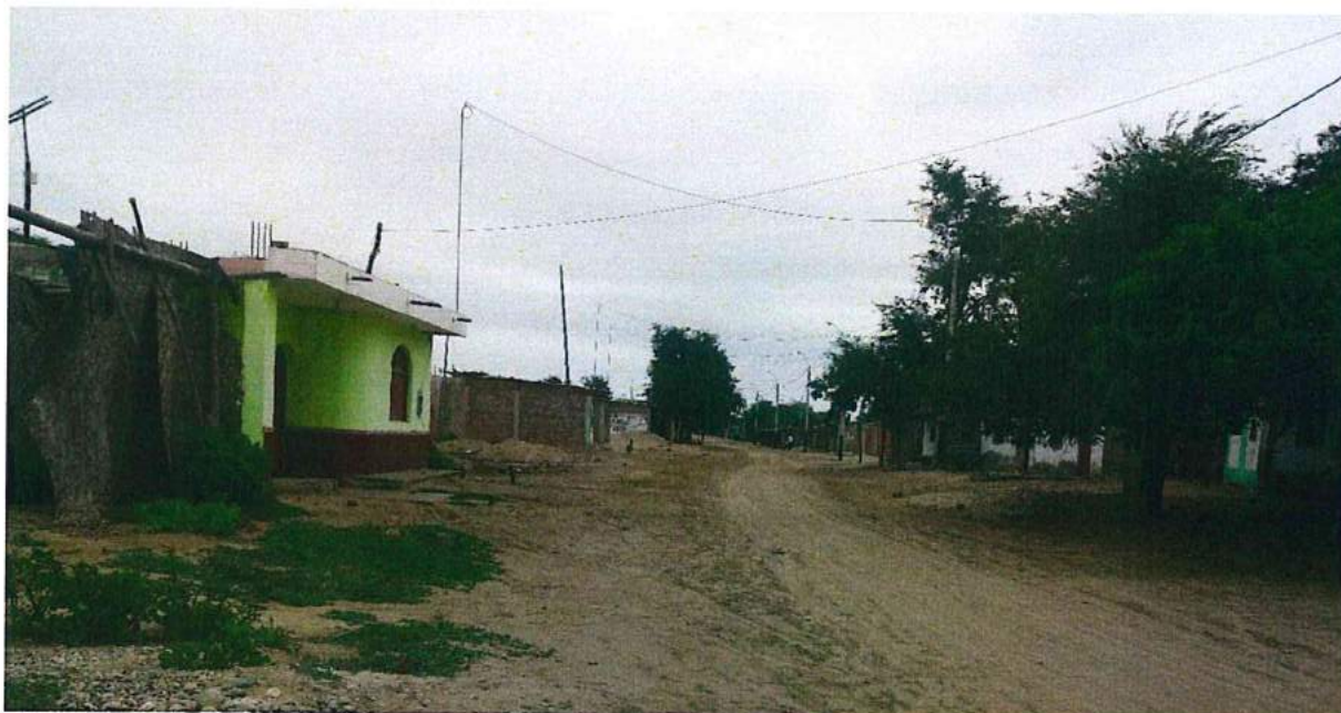
Foto N ° 02: Viviendas de concreto y ladrillo sobre zona inundada durante el FEN 2017
