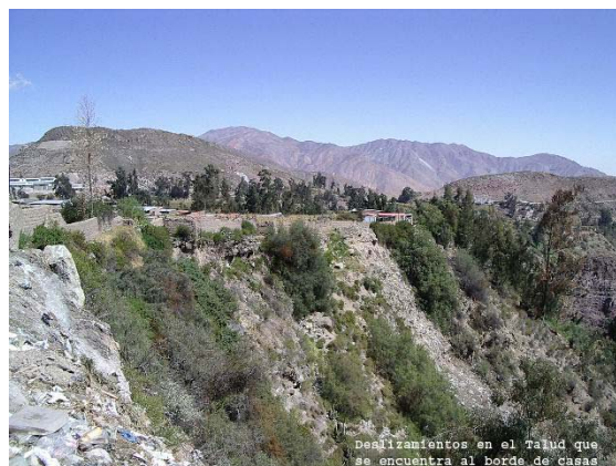
Vista de la vulnerabilidad del suelo sobre quebradas, con viviendas en el borde característico del entorno de la Ciudad de Tarata.
