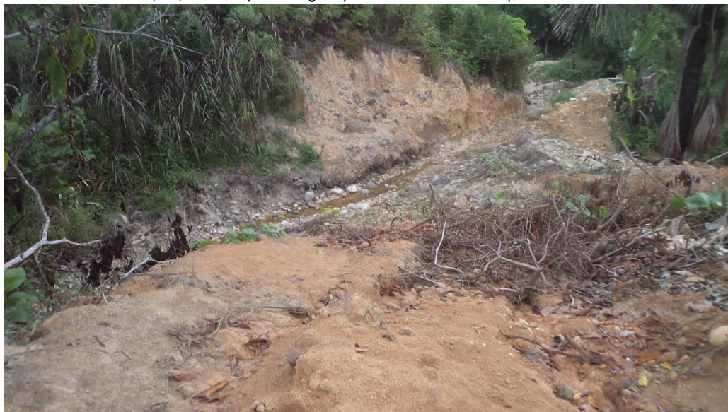
Foto N° 03, 04, 05: Cuerpos de Agua que atraviesan el centro poblado de Santa Lucía
