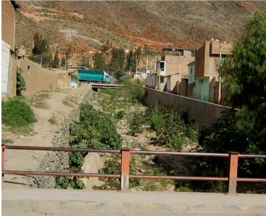
Foto N° 27 Vista aguas arriba de la quebrada Llicua desde la carretera a Tingo María, la cual se ha encauzado en su tramo final.
