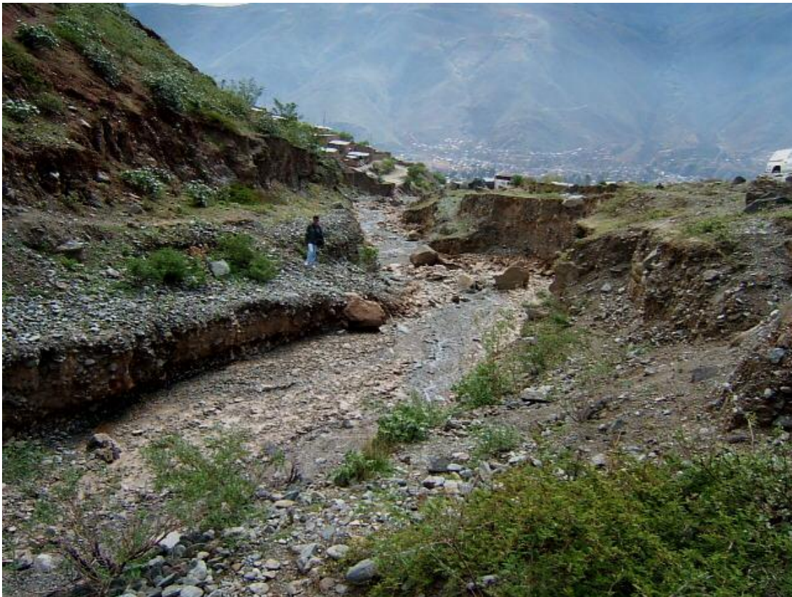
Foto N° 5 Vista aguas abajo de la quebrada Tingoragra. Se aprecian niveles o terrazas de origen proluvial (huaycos), superficiales, superiores a los 2 m.
