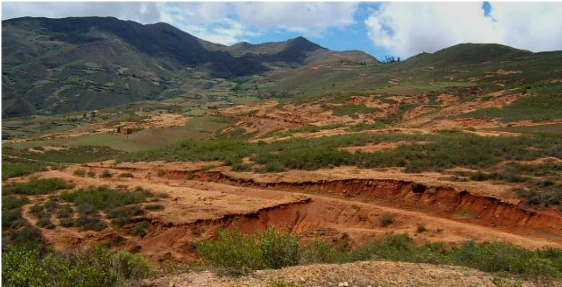
Foto N° 34 Vista hacia el oeste sobre la trocha carrozable Jactay-Chacmapampa, afectada por surcos y cárcavas. En este sector se tiene un espesor de suelo residual importante.
