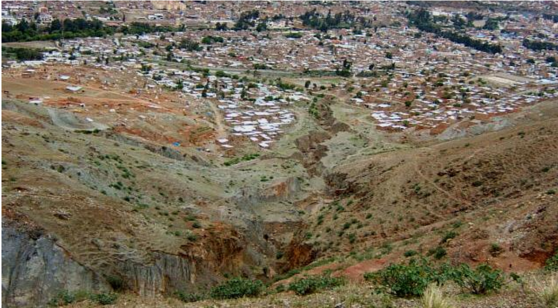
Foto N° 21 Vista aguas debajo de la quebrada La Florida donde se muestra el abanico de un huayco antiguo ocupado por asentamientos humanos en ambas márgenes.
