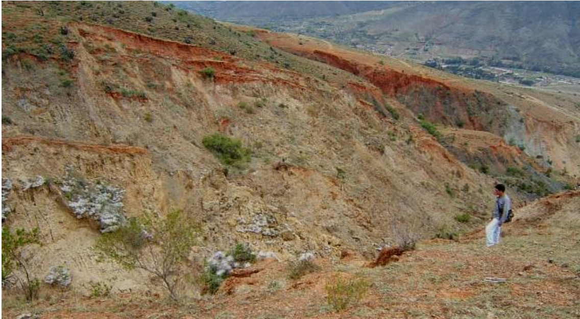
Foto N° 16 Deslizamiento complejo que muestra movimiento rotacional y traslacional, cárcava central de la quebrada La Florida.
