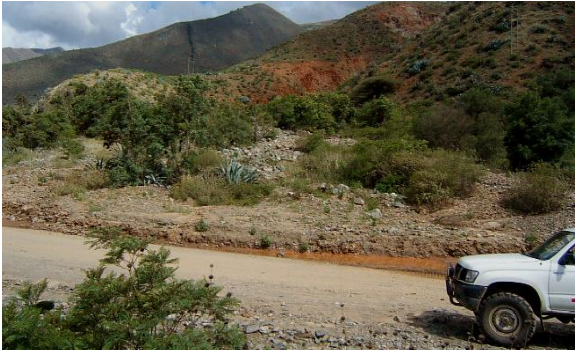
Foto N° 33 Tramo de la carretera Huánuco-La Unión frecuentemente afectada por huaycos que interrumpen el tráfico normal.
