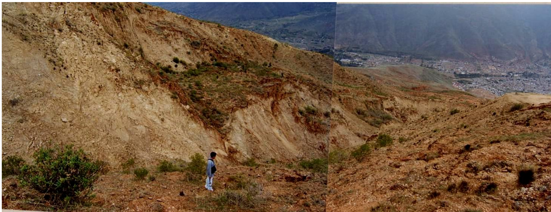
Foto N° 20 Ejemplo de otro deslizamiento de tipo rotacional en la cárcava derecha de la quebrada La Florida. Se aprecia la superficie de deslizamiento cóncava así como aparentemente, procesos de asentamientos de hace algunos años con reactivaciones recientes en la cara libre a la quebrada. Zona con alto potencial para generación de huaycos.
