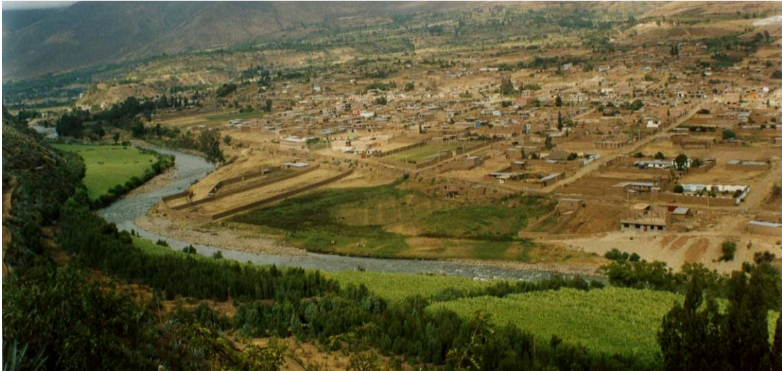
Foto N° 32 Sector de Pillcomarca, terraza baja susceptible a inundaciones excepcionales a ocasionales.
