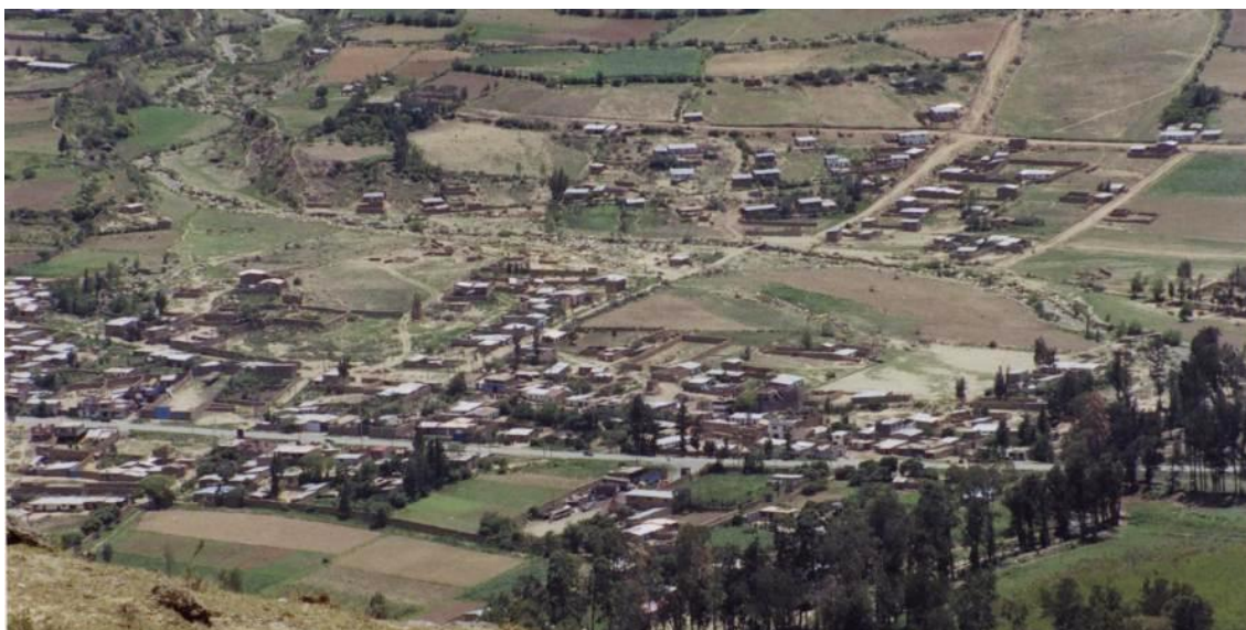
Foto N° 29 Vista aguas arriba del sector de La Esperanza donde se distingue la curva en el cauce de la quebrada que produjo un huayco reciente.
