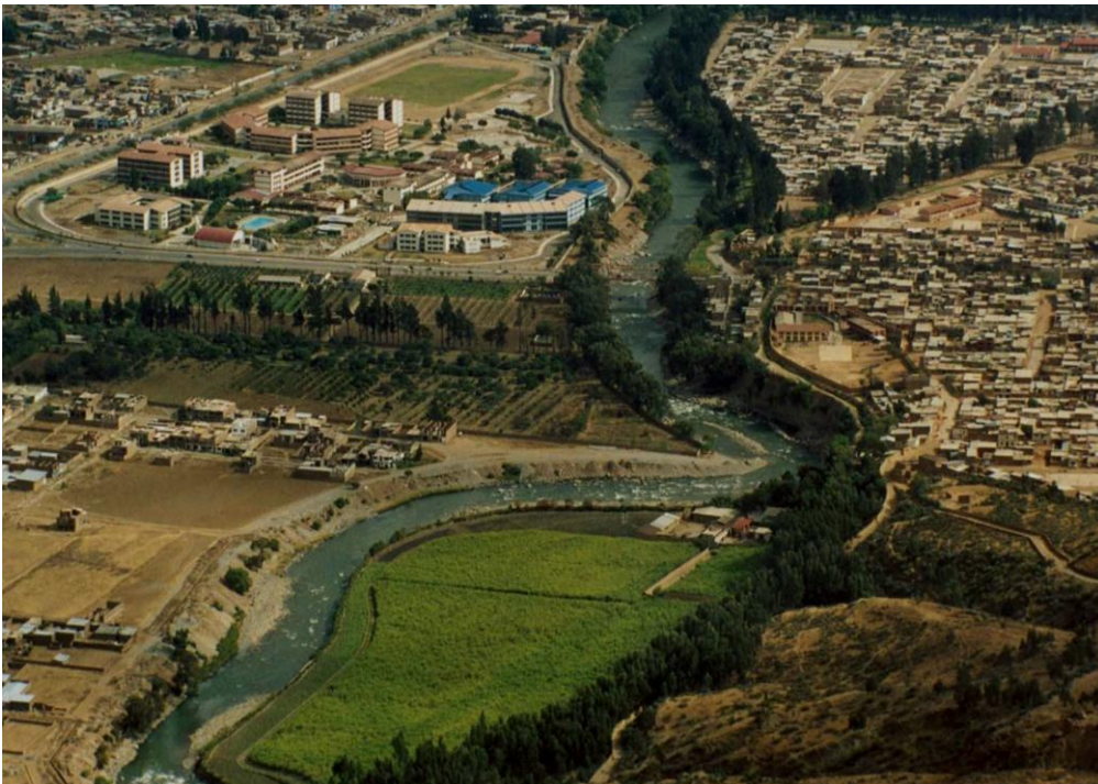
Foto N° 31 Vista aguas abajo del río Huallaga en el sector de la Universidad de Huánuco, cauce divagante, encajonado susceptible a inundaciones excepcionales y erosión fluvial.
