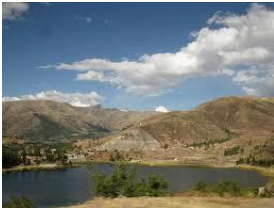
Escombros acumulados al borde de la quebrada en la parte baja y parte media de la mc
