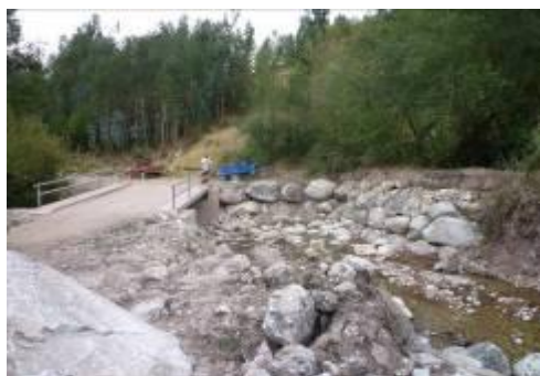
Pontón emplazado en un tramo curvo / Bolones hasta de 1.80 m de diámetro El enrocamiento, es posterior al aluvión
