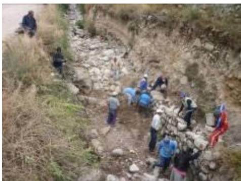
Descolmatación y encauzamiento
