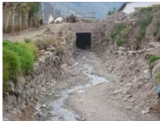
Sección final del conducto cubierto, en la zona de entrega al río Vilcanota
