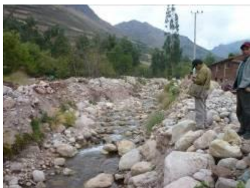
El cauce (después de su descolmatación ) y viviendas adyacentes al río
