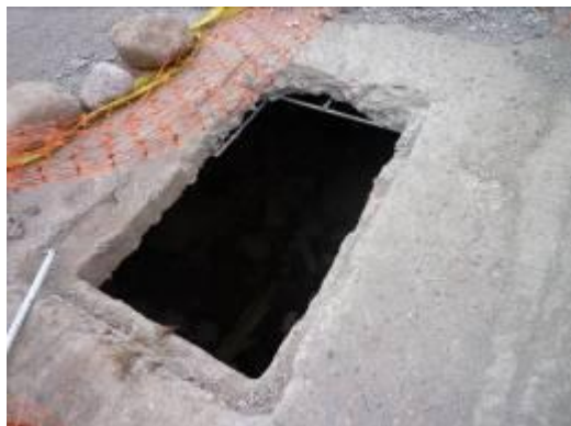
Construcción de ventanas de inspección en el tramo cubierto del encauzamiento
