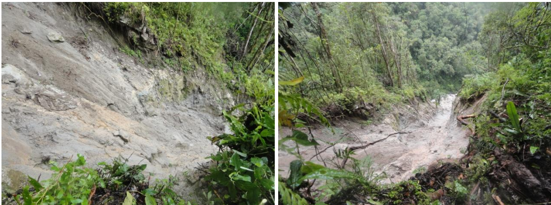
Foto 22 y 23 Deslizamiento en plena actividad, nótese el movimiento de las rocas y el flujo de lodo en el pie.
