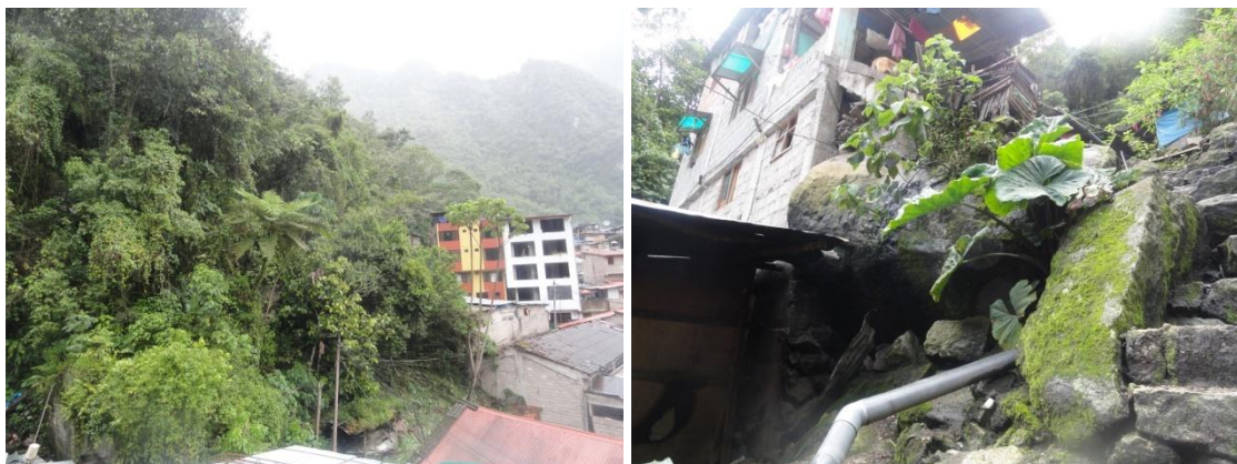
Foto 78 y 79 Desprendimiento de rocas en laderas
