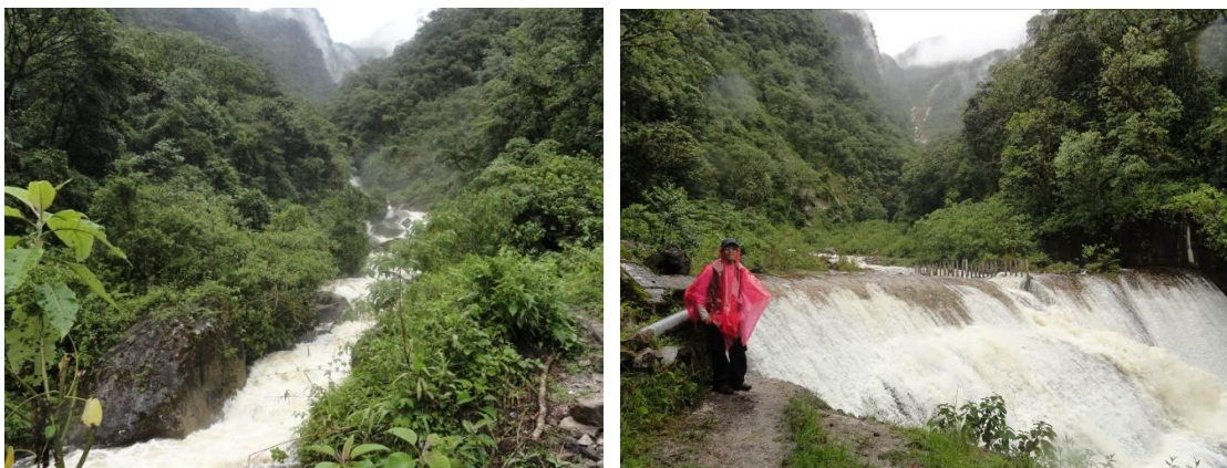
Foto 64 y 65 Disipadores de energía en lecho de cauce.
