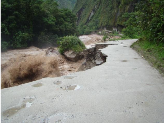
Foto 41 y 42; Vista de la socavación y derrumbe de algunos tramos de la carretera hacia la ciudadela de Machupicchu.
