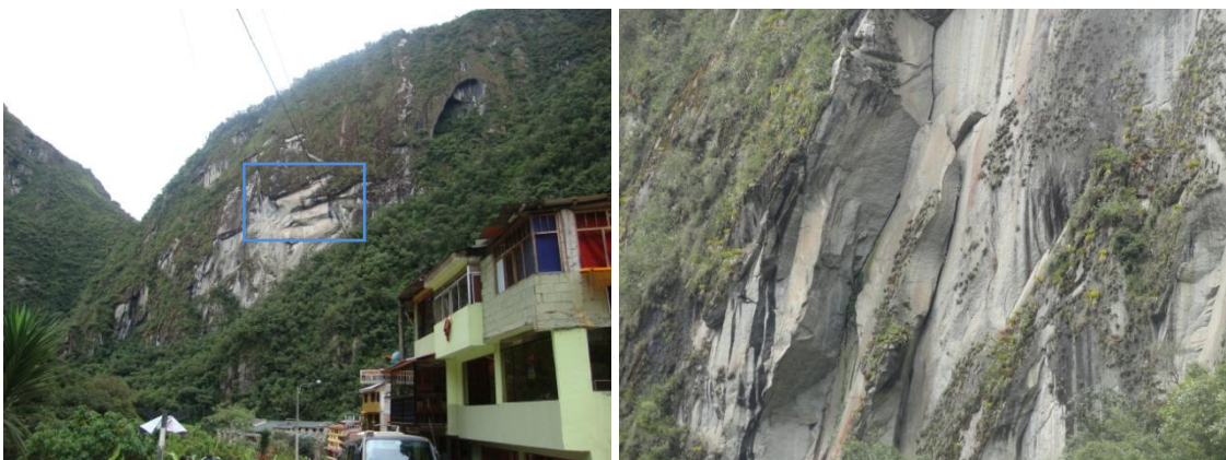
Foto 30 y 31 Caída de bloques rocosos en la ladera Este del cerro Putucusi poniendo en peligro la estación hacia la Hidroeléctrica de Machupicchu y varios hoteles asentados en la parte baja de la ladera.
