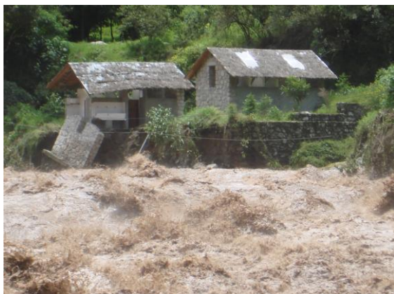
Foto 56 y 57: Parte de la pared de los servicios higiénicos colapsado, troncos y escombros atascados en la bocanilla de la Central Hidroeléctrica, ambos hallados en el km. 107 de propiedad de EGEMSA.
