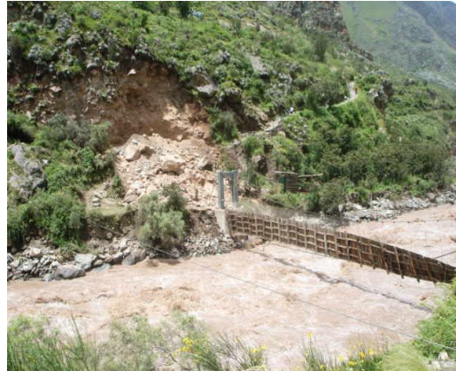
Foto 52 y 53: Derrumbe ocurrido en el puente de Piscacucho, que cortó uno de sus cables, quedando el puente girado. Se perdieron dos personas y se observa salvándose otras 3 que lograron pasar dicho puente.
