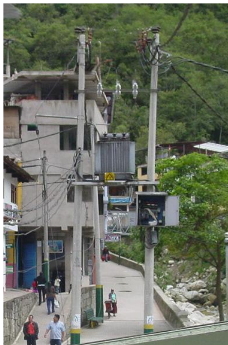
Foto 89 y 90. Red eléctrica de alumbrado público y postes transformadores de energía.
