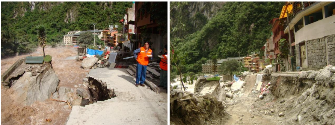
Foto 39 y 40 Vista de la socavación del la margen derecha del río Vilcanota.
