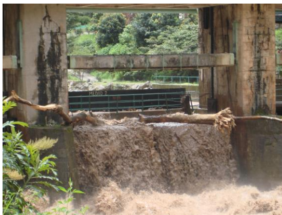
Foto 56 y 57: Parte de la pared de los servicios higiénicos colapsado, troncos y escombros atascados en la bocanilla de la Central Hidroeléctrica, ambos hallados en el km. 107 de propiedad de EGEMSA.
