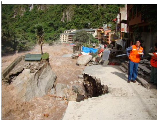
Foto 58 y 59: Estragos causados por el caudal aprox. de 1200 m 3 /seg en la margen derecha del río Vilcanota y socavamiento y pérdida del malecón y plataforma de la vía carrozable en dirección a ciudadela.
