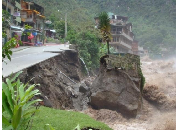
Foto 41 y 42; Vista de la socavación y derrumbe de algunos tramos de la carretera hacia la ciudadela de Machupicchu.
