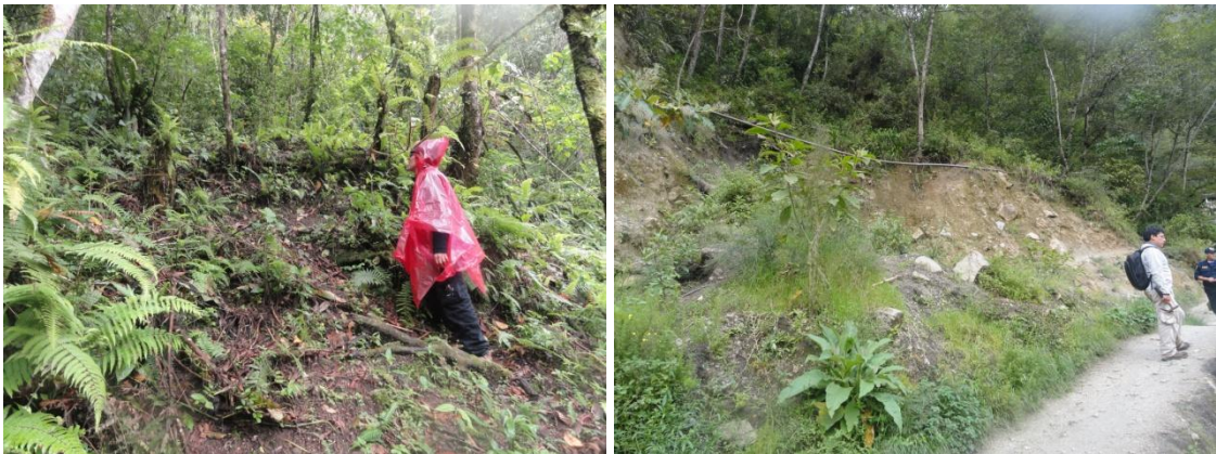
Foto 15 y 16; Depósitos coluviales en las laderas del Cero Media Naranja y Las Orquídeas.
