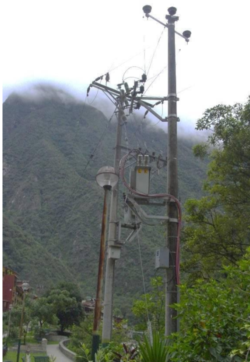
Foto 89 y 90. Red eléctrica de alumbrado público y postes transformadores de energía.
