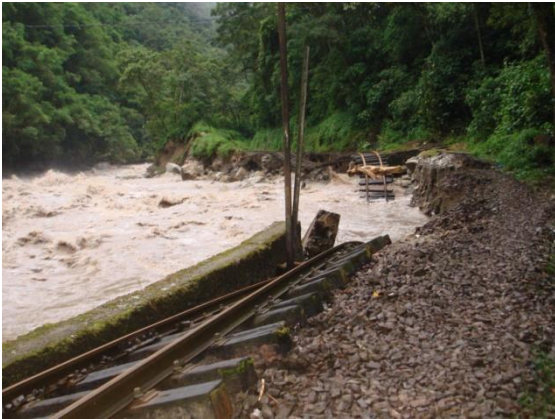
Foto 43 y 44; Vista de la socavación y derrumbe de algunos tramos del ferrocarril.
