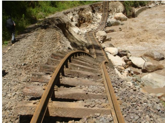
Foto 43 y 44; Vista de la socavación y derrumbe de algunos tramos del ferrocarril.
