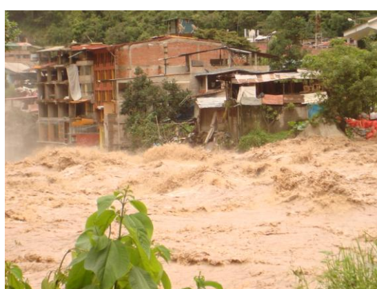
Foto 58 y 59: Estragos causados por el caudal aprox. de 1200 m 3 /seg en la margen derecha del río Vilcanota y socavamiento y pérdida del malecón y plataforma de la vía carrozable en dirección a ciudadela.
