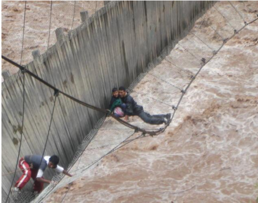
Foto 52 y 53: Derrumbe ocurrido en el puente de Piscacucho, que cortó uno de sus cables, quedando el puente girado. Se perdieron dos personas y se observa salvándose otras 3 que lograron pasar dicho puente.
