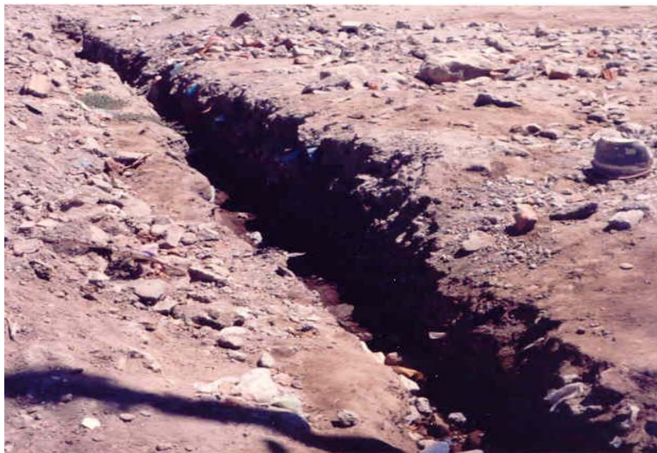
Foto 8.- Drenaje sector Urb. Campo Ferial, nótese el material de relleno empleado
