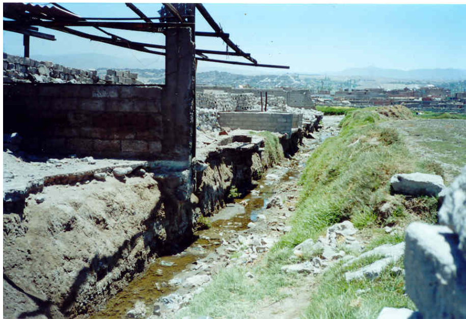
Foto 14.- Vista drenaje sector Norte Urb. Los Cristales
