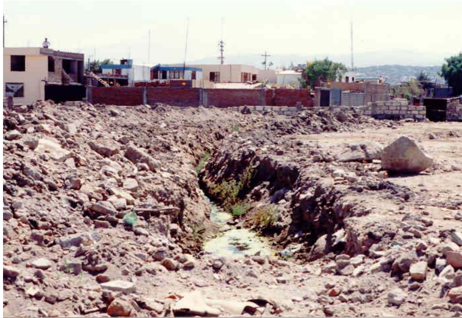
Foto 9.- Vista del drenaje colector en la Urb. Las Magnolias
