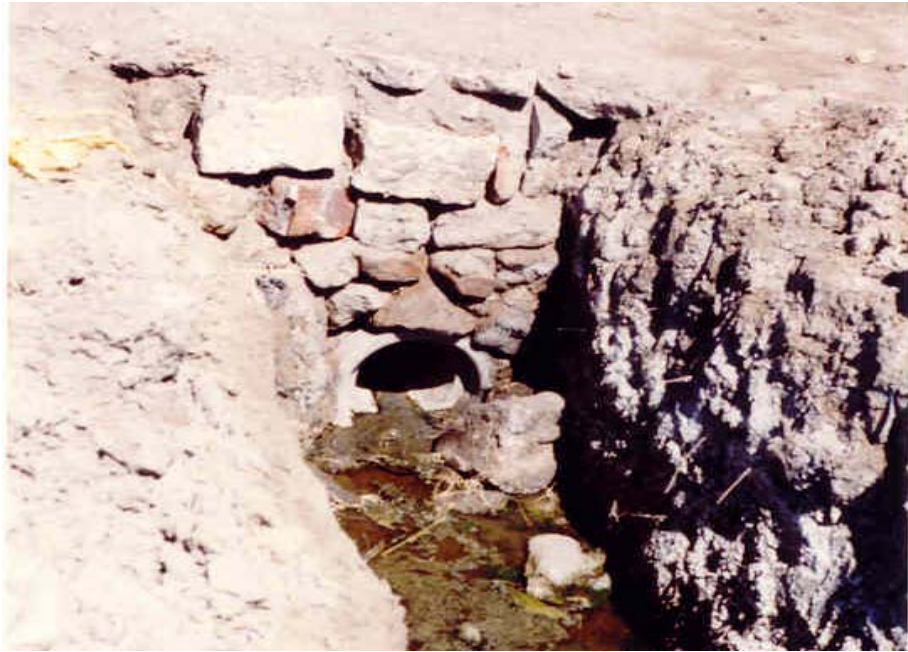
Foto 5.- Drenaje existente al ingreso de la Urb. Las Magnolias
