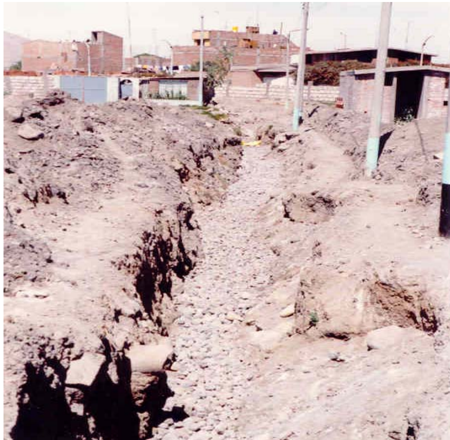
Foto 6.- Vista del drenaje ejecutado en la Urb. Las Magnolias
