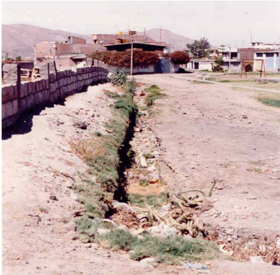
Foto 7.- Drenaje existente frente a la Urb. Las Magnolias
