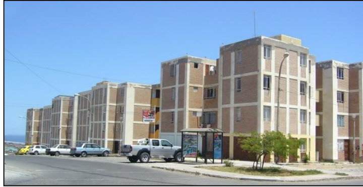
FOTO N° 5: Edificios de ENACE. Fuente: Equipo técnico
