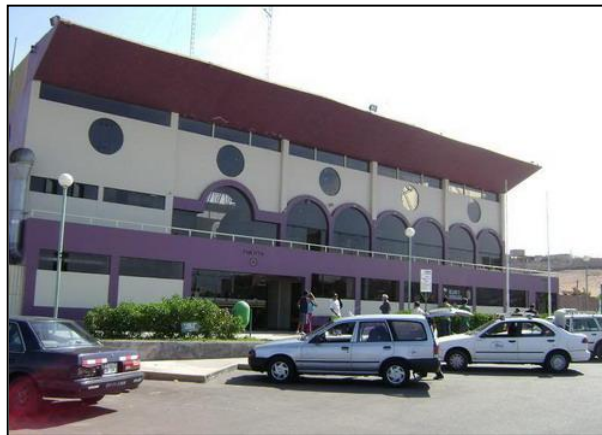
FOTO N° 48: Terminal Terrestre de Mollendo.
