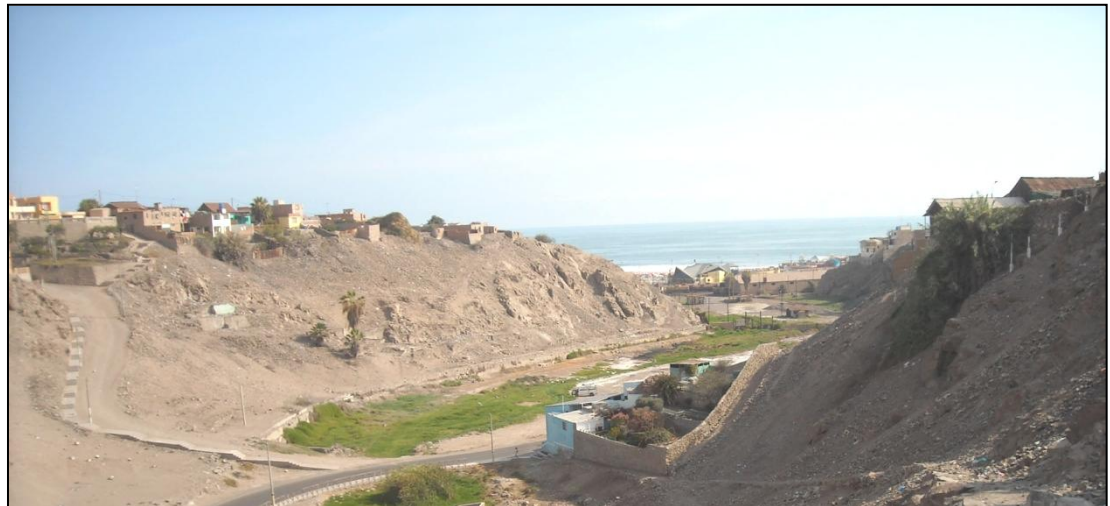
FOTO N° 8: Quebrada Yalu y viviendas de la Urb. Inclán.
