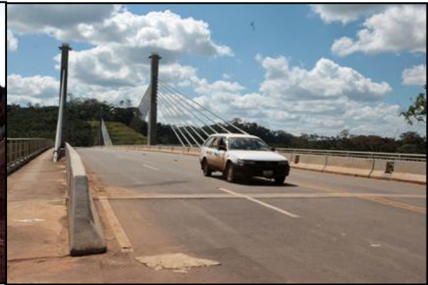
FOTO N° 2: Avances carretera interoceánica
