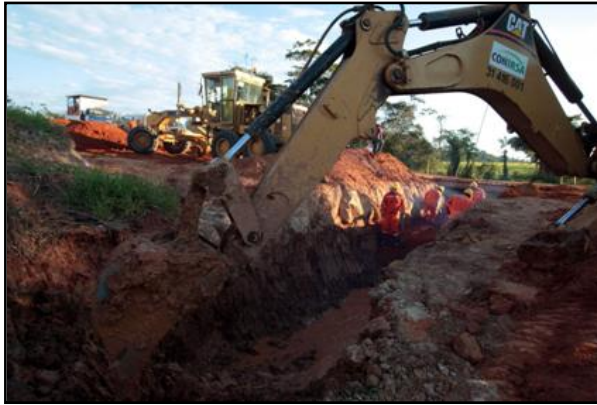
FOTO N° 1: Obras carretera Interoceánica
