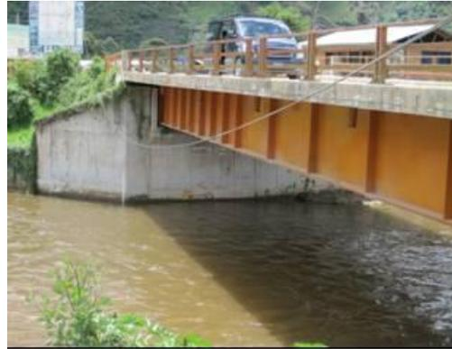
Por otro lado hay que señalar que estos cables cruzan cuerpos de agua sin el adecuado sostenimiento, en la fotografía se puede ver que este cable se encuentra muy próximo al río. La falta de conocimiento y manejo de las instalaciones puede provocar desastres como en este caso donde se observa que dichas instalaciones se han realizado informalmente. Un corto circuito podría ocasiona un incendio.
