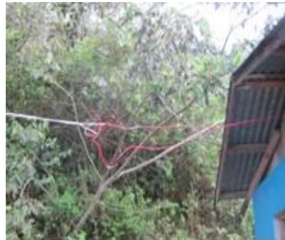
En la fotografía se observa la poza de almacenamiento y cloración ubicada en la quebrada San Alberto, donde se observa el inadecuado manejo de sus instalaciones eléctricas, las cuales pueden provocar un corto circuito.
