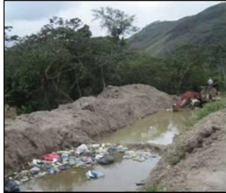
Los residuos del Botadero se encuentran descubiertos expuestos a las intensas lluvias, es urgente que este botadero cuente con un canal de coronación como un manejo urgente de las aguas de lluvias y así evitar que estas aguas tengan contacto directo con los desechos, porque de no contar con este canal hay la posibilidad que estos residuos se deslicen por la quebrada.
