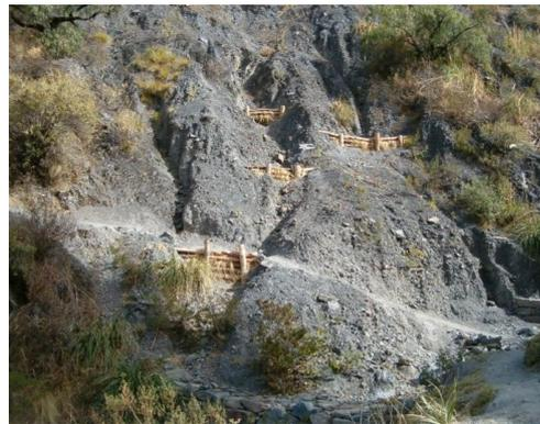
Plan temático de los diques de piedras. Los diques están puestos uno tras el otro en forma de gradas con el propósito de reducir la energía cinética del agua, evitar la socavación de fondo y retener material sólido de arrastre. Los diques de piedras vienen acompañados por 2 árboles y 2 arbustos en la parte superior como en la parte inferior.
