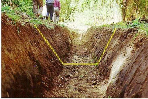
Las paredes de las zanjas deben tener un talud o inclinación para impedir su desmoronamiento. El valor del talud depende del tipo de material. En suelos muy arenosos, el talud será bastante alto, en cambio, en roca o grava cementada, puede ser vertical.
