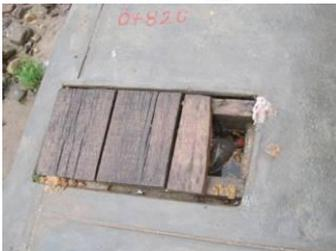
En la ciudad de Oxapampa se ha observado que las redes de alcantarillado en algunos sectores se encuentran saturadas. En la fotografía se puede apreciar un buzón de desagüe donde las fecas humanas se encuentran expuestas las cuales por las lluvias son arrastradas contaminando el suelo.
