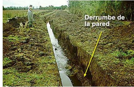
Las Zanjas construidas con talud no adecuado, produciéndose un derrumbe de la pared, que provoca socavamiento progresivo por la mayor velocidad del agua, que se genera al estrecharse la sección.
