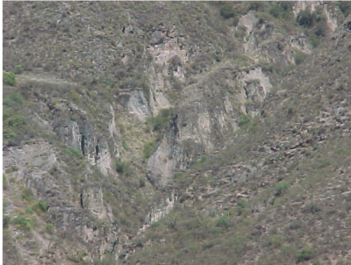
Foto 15: Quebrada Querapuquio, donde se producen anualmente derrumbes y deslizamientos.
