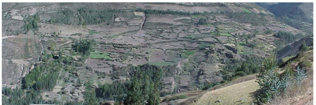
Foto 6: Vista panorámica del deslizamiento activo Zona E, encima de la escarpa se sitúa un canal de irrigación, y por debajo se observan los diferentes deslizamientos activos y en algunos casos forestados para su estabilización.
