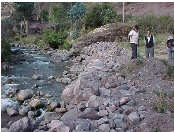
Foto 2: Terrenos de cultivos afectados por el aluvión del año 2003. Actualmente se está protegiendo el cauce con bloques de rocas.
