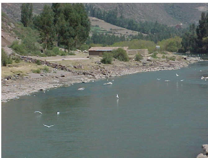
Foto 23: Margen izquierda del río Vilcanota, con peligro muy alto frente a inundaciones.
