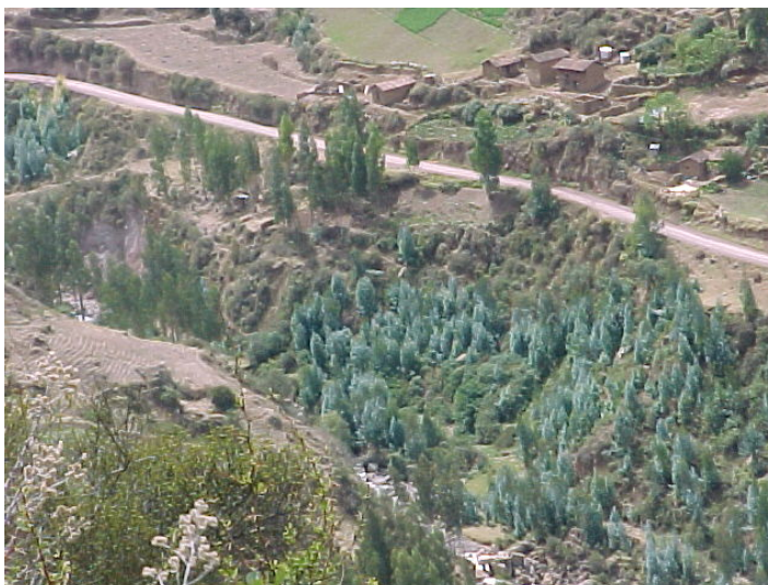
Foto 13: Deslizamientos activos en la base del deslizamiento F-2-2, producto de erosión del río Cochoc en su margen derecha en el sector de Accha Baja.
