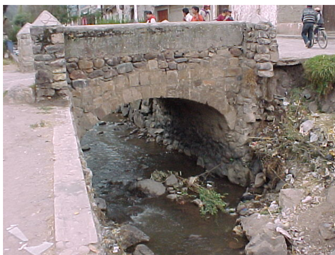
Foto 20: puente sobre el río Cochoc en la intersección con la avenida Simón Bolívar.
