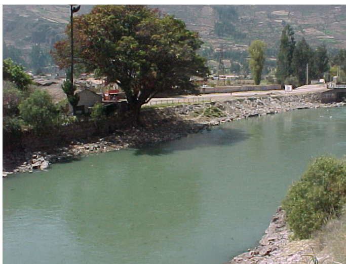
Foto 25: Muro de protección provisional construido por los propietarios de la vivienda que no reúne condiciones necesarias para su protección.
