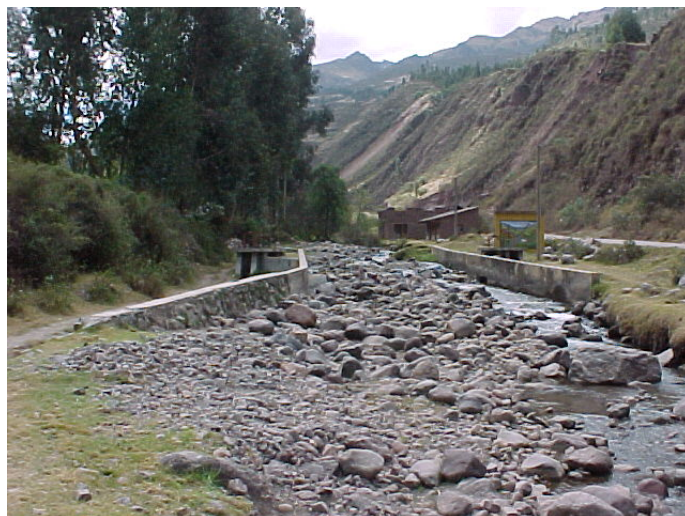
Foto 17: Cauce del río Cochoc muy estrecho con peligro muy alto frente a aluviones e inundaciones (entrada de la ciudad de Calca).
