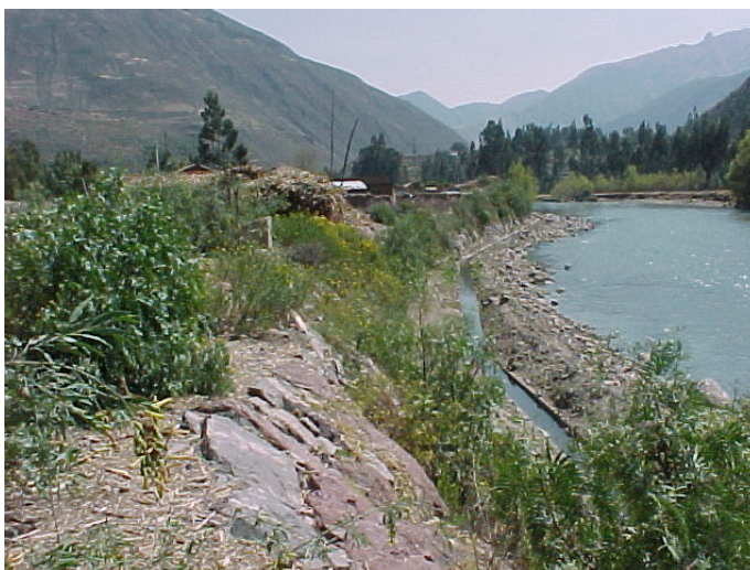
Foto 24: Encauzamiento del río Vilcanota en el sector de Chimpacalca.
