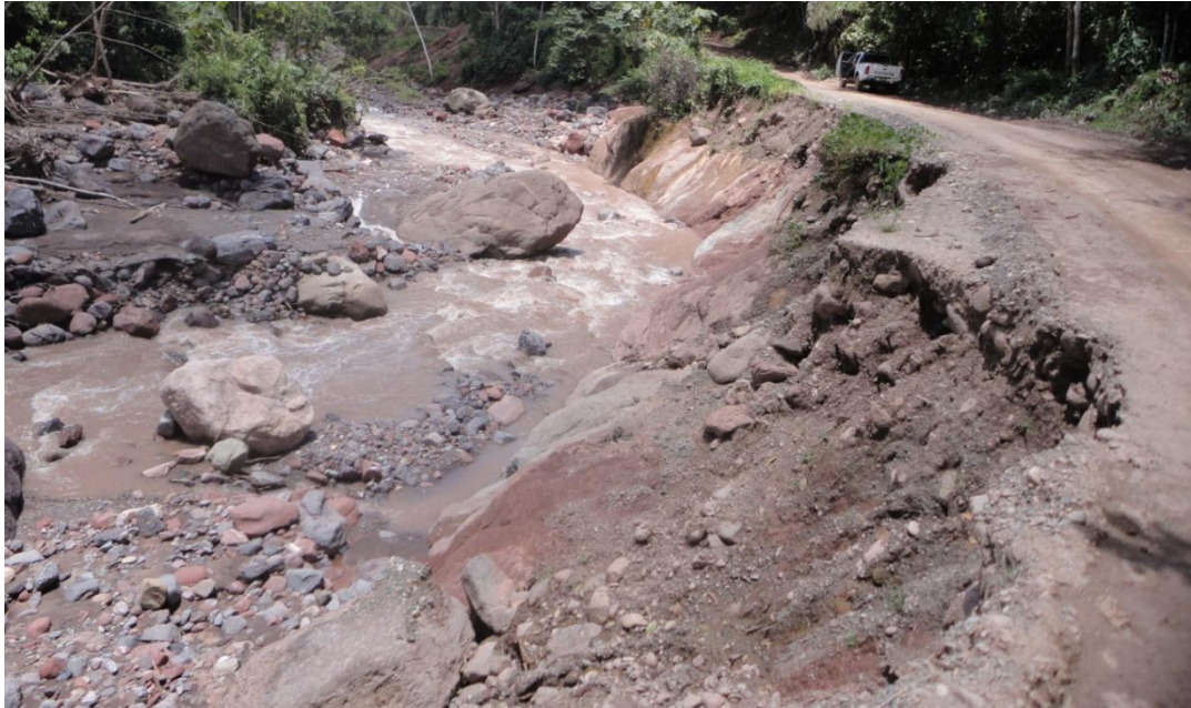
Foto 3.- Parte media del cauce del río Sivia, se muestra un canal único y definido.
