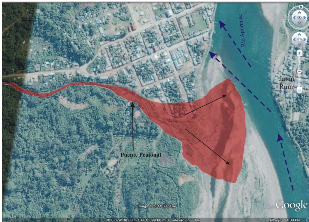
Figura 9.- Sector de Sivia y Jatun Rumi, y el depósito generado por el flujo de detritos (huayco). Las flechas de color azul indican la dirección de la corriente del río Apurímac y las de color negro indican la dirección del flujo de detritos.
