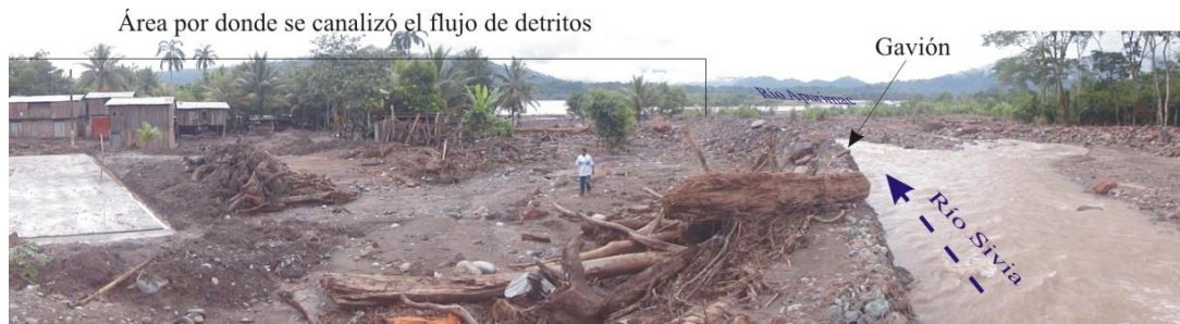
Foto 23.- Gavión ubicado en la margen izquierda del río Sivia, cubierto por restos de troncos de árboles.
