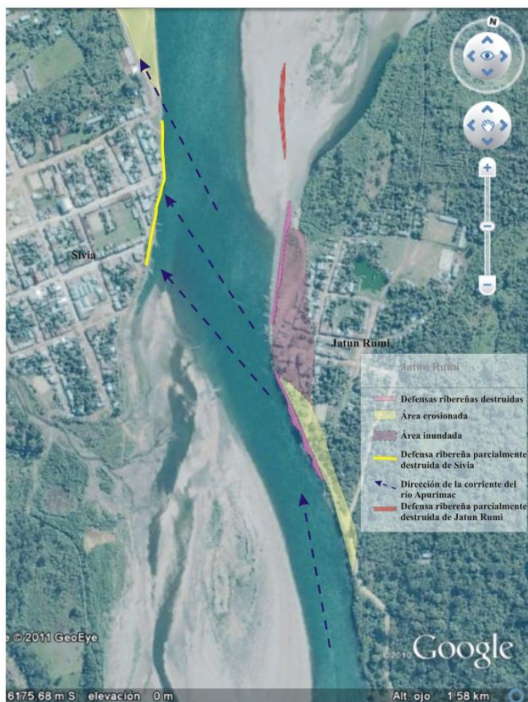
Figura7.- Se muestra las zonas afectadas por la erosión fluvial del río Apurímac y la dirección de la corriente en el río Apurímac.
