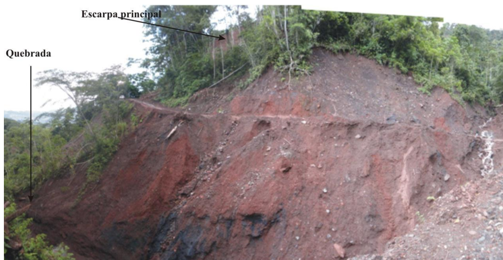
Foto 26.- Deslizamiento que afecta la carretera afirmada Sivia-Balsamuyocc.
