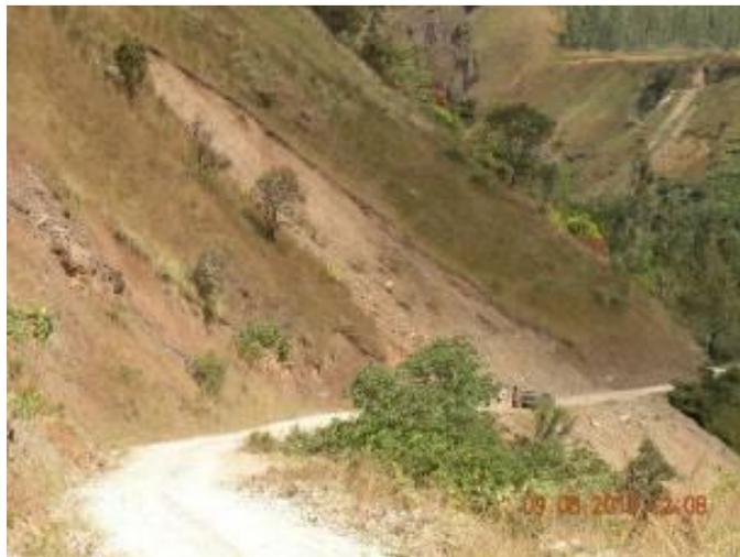
Foto N° 7: Vista derecha: Deslizamiento en la carretera Santa Teresa Hidroeléctrica.
