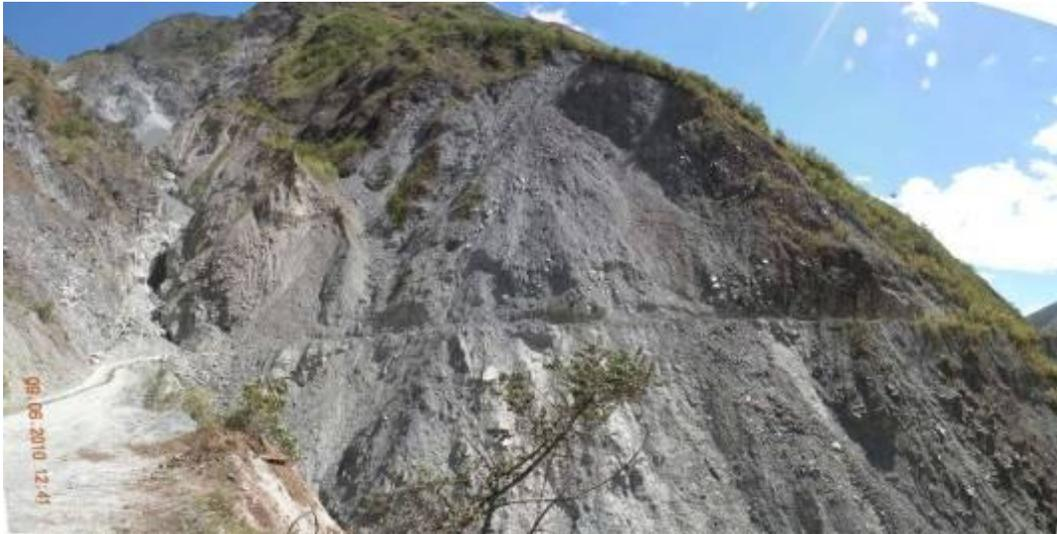
Foto N° 8: Deslizamiento de Colcamayo a la altura de la carretera
