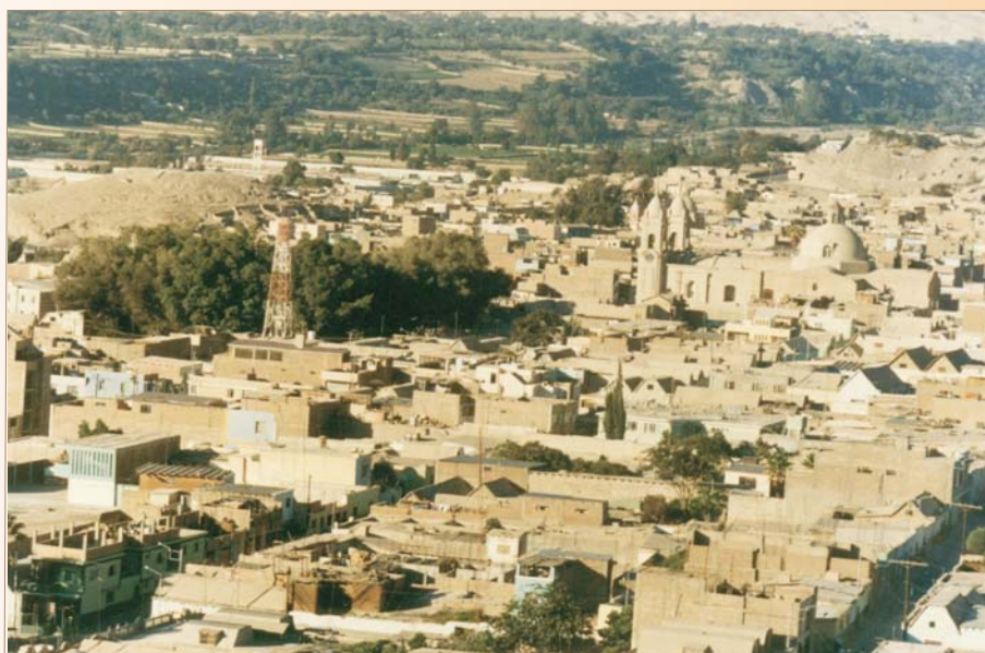
Antes del sismo
