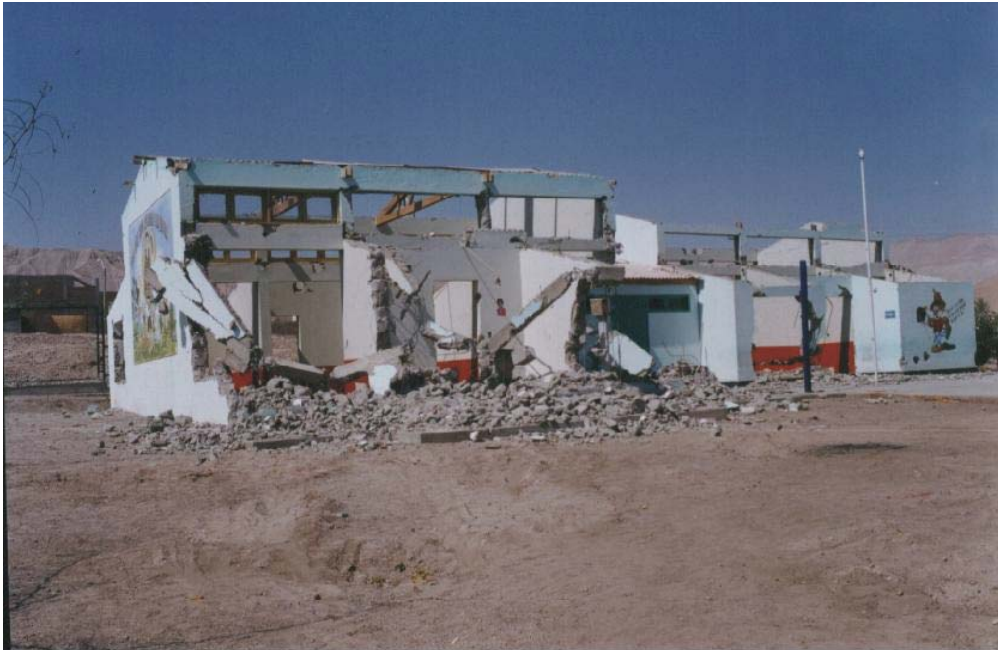
Foto N° 11: Vista del Centro Educativo Inicial San Antonio colapsado (deficiencias en el proceso constructivo)
