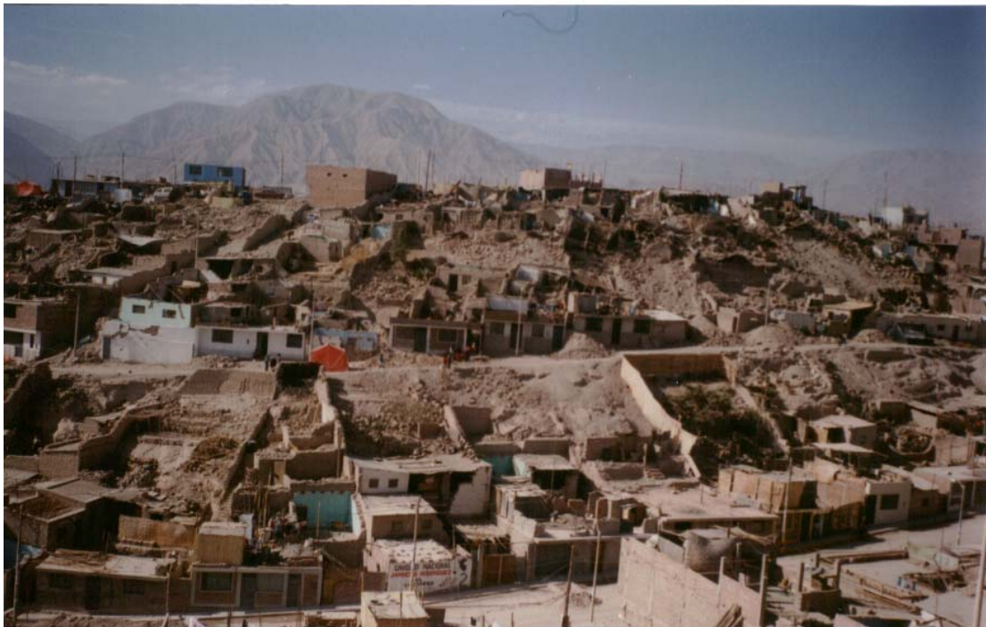
Foto N° 16. Cerro San Francisco: Vista parcial daños en viviendas.
