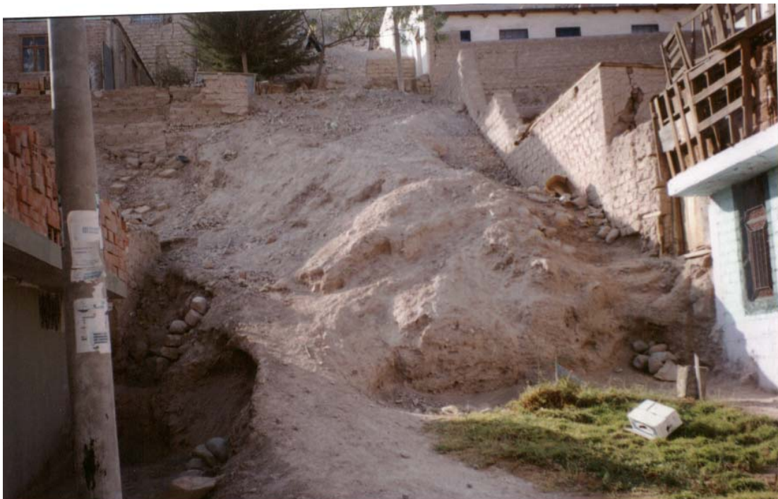
Foto N° 14. Cerro San Francisco: Vista parcial de talud.
