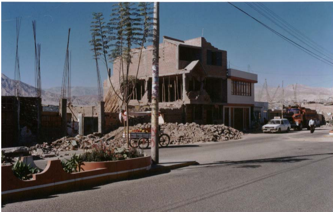
Foto N° 12. Vivienda casi totalmente destruida.
