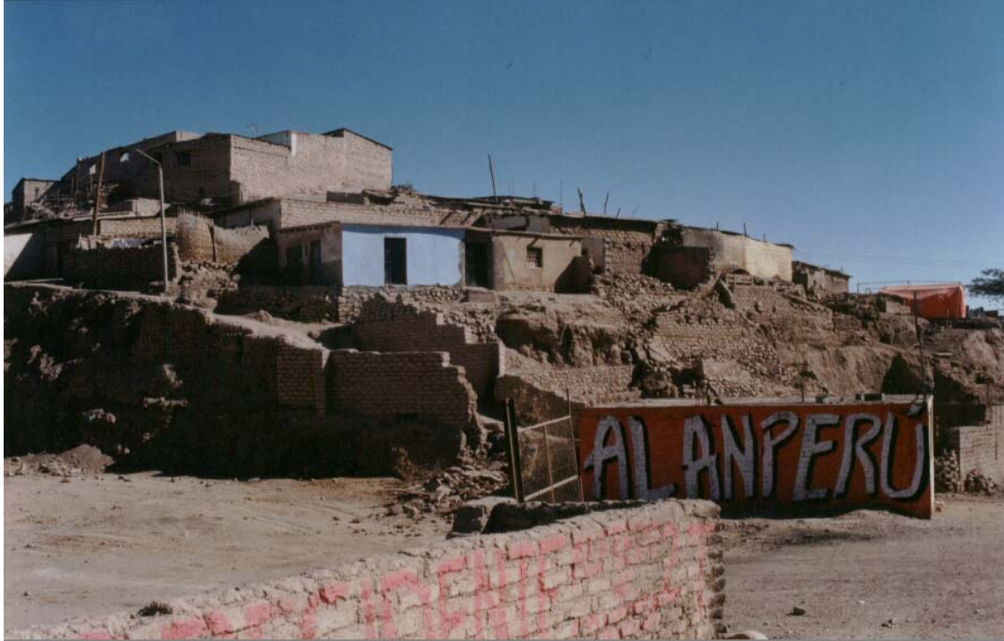
Foto N° 09. Cerro San Francisco: Vista de viviendas construidas con adobe
