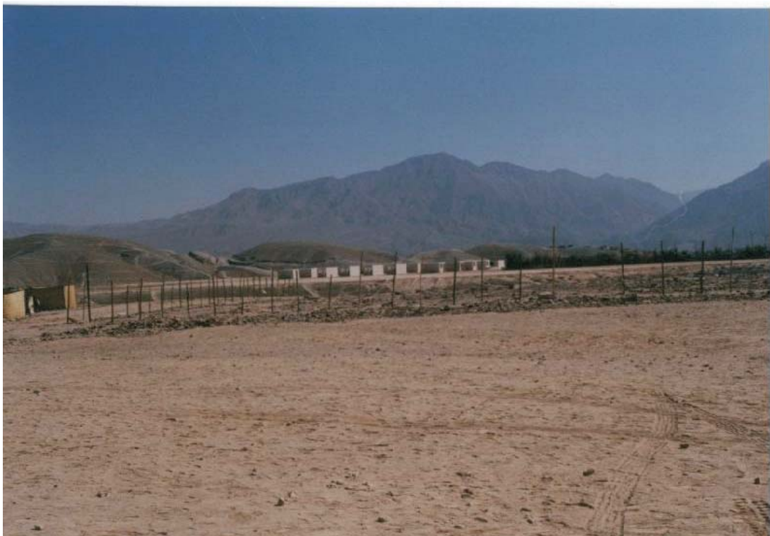
Foto N° 08: Vista del AA. HH. Chen Chen, se observan los modulos de viviendas
