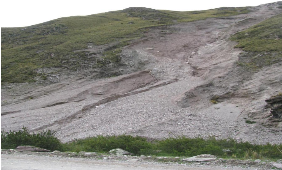
Foto N° 08: Deslizamiento en el talud del curso medio del río Shullcas (altura de Acopalca)
