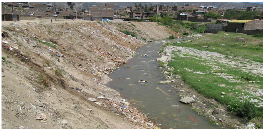
Foto N° 12: Curso del río Shullcas aguas arriba del puente Carrión, susceptible de inundaciones.
