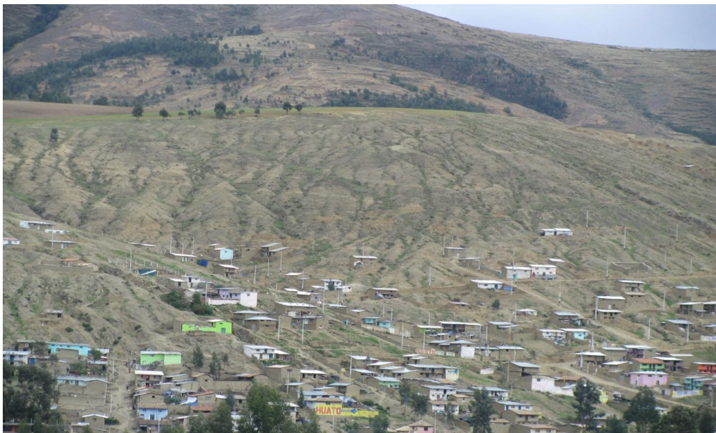
Foto N° 17: AAHH san Cristóbal, ubicado en la zona de expansión urbana hacia el norte de la ciudad de Huancayo. Nótese la fuerte erosión superficial por lluvias.
