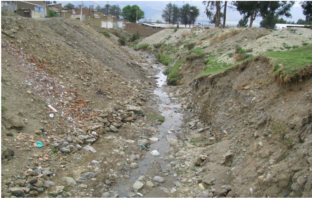
Foto N° 18: Curso del río Chilca, mostrando erosiones en el talud y colmataciones por el vertido de desmonte.
