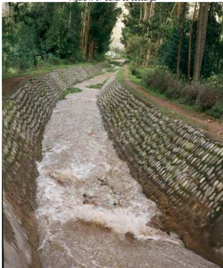
Figura N°67 Canal de descarga
