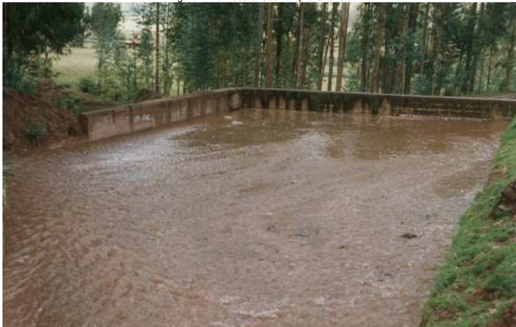
Figura N°66 Descarga de aguas a la salida del desarenador.
