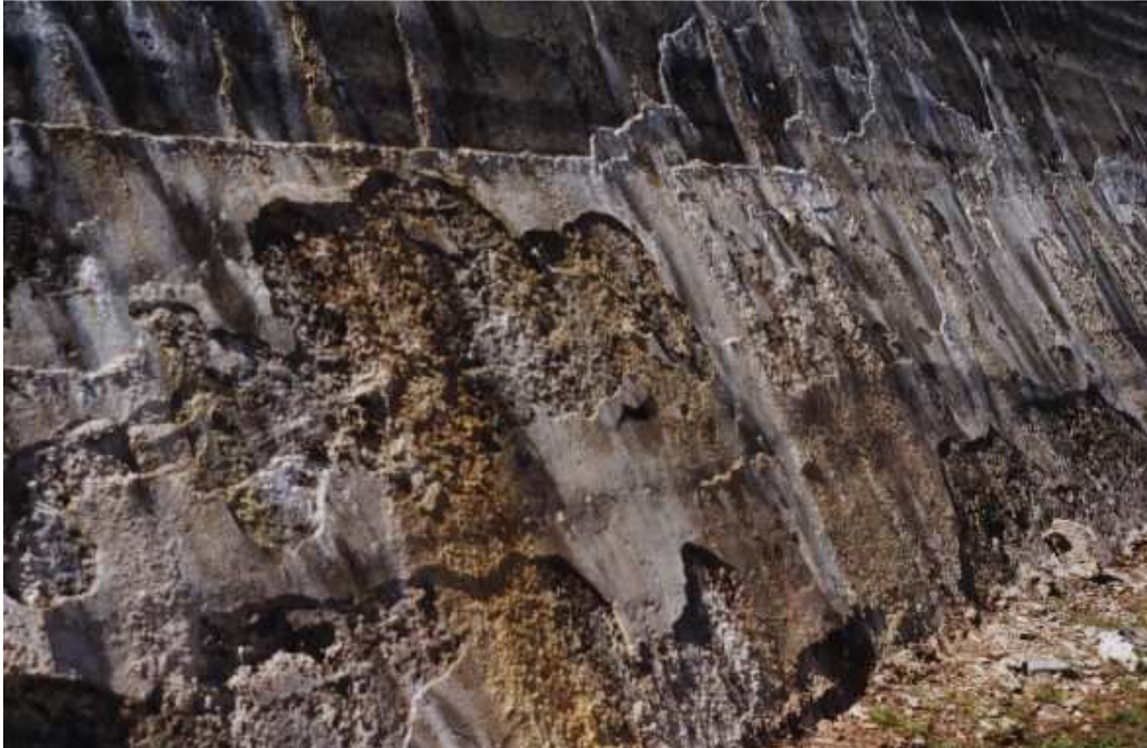
Figura N°60 Deterioro del concreto intemperizada (foto mayo de 1999)
