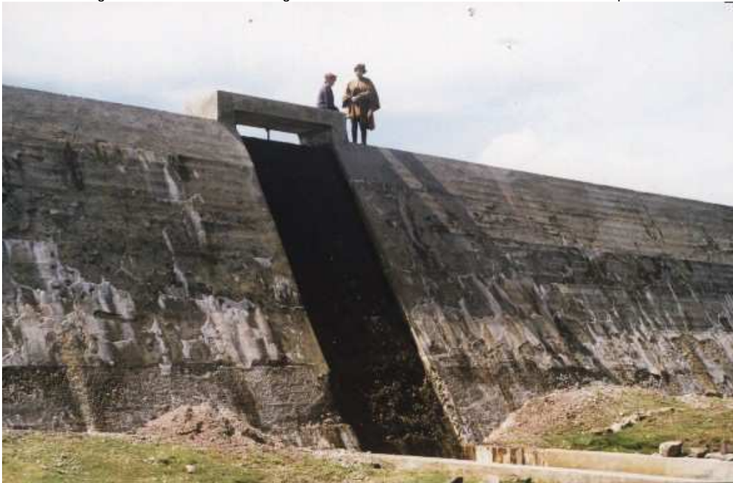
Figura N°60 Deterioro del concreto intemperizada (foto mayo de 1999)
