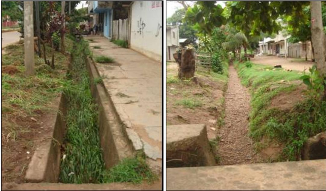
Foto N° 27. Sistema de drenaje con problemas de Sedimentación y vegetación. Problemas de falta de mantenimiento.
