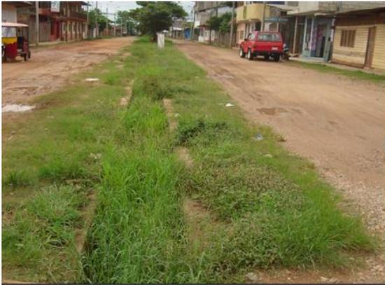
Sistema de Drenaje. Canal de Concreto colmatado Con sedimentos y con vegetación, en el Jr. Moquequa.
