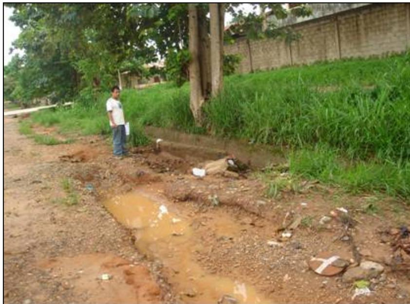
Foto N° 28. Canal de drenaje en colapso por rebose del flujo.
