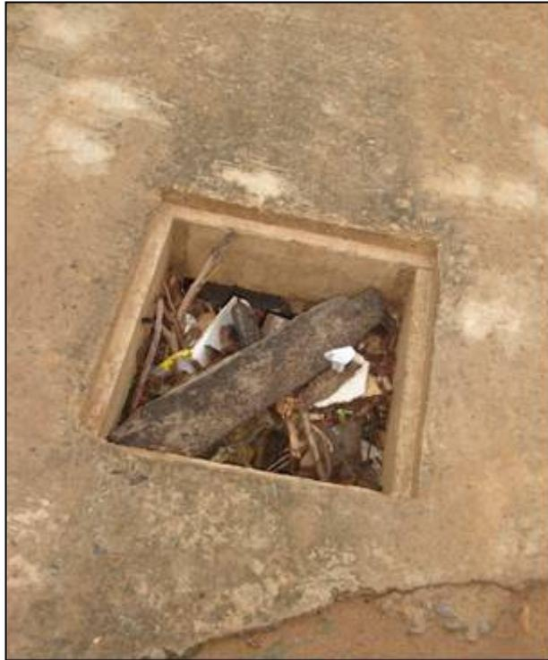
Foto N° 29. Buzón de Inspección del Sistema de Drenaje, se observa la acumulación de basura.
