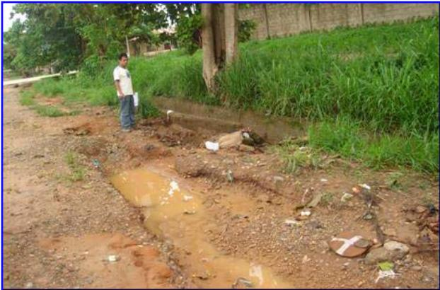
Sistema de Drenaje. Izquierda, Se observa el buzón de inspección, colapsado por acumulación de desechos y basura. Derecha, canal de concreto colapsado por rebose del flujo y agrietamiento del canal
