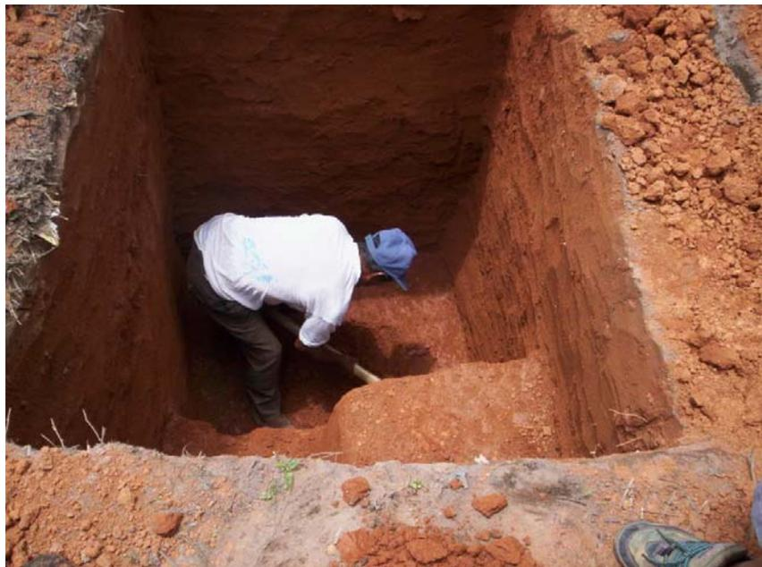
Foto N° 38. Vista al interior de la calicata C8 y toma de muestra alterada
