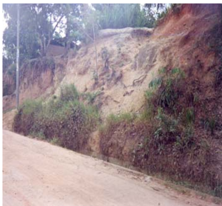
F-4: Se observa la erosión hídrica del suelo por acción de las lluvias (Sector Belén)
