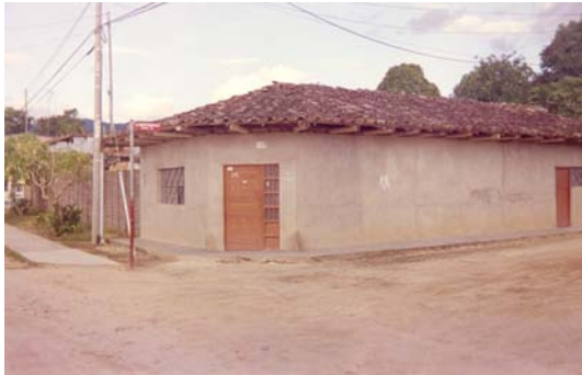
F-2: Construcción de adobe, enlucida con mortero de arena y cemento. (esquina de Jirón Puno y Jirón. Independencia - sector Zaragoza)
