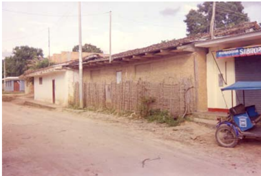
F-3: Edificación construida con caña y barro, techo con vigas de madera. (cuadra 6 - calle 20 de Abril - sector Zaragoza)
