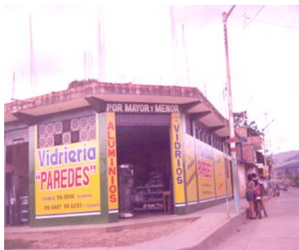
F-12: Edificación que está constituido por columnas, vigas y techo aligerado (sector Calvario)
