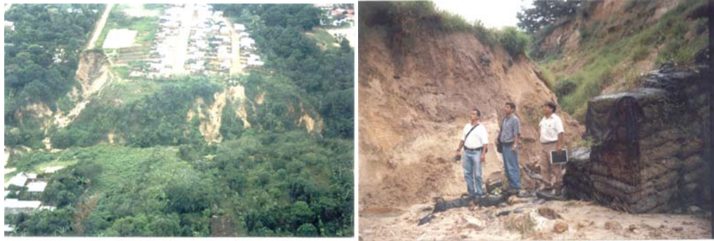
F-7: Barranco Tumino, vista aérea y corte. Características de erosión hídrica en relación directa con el suelo arenoso
