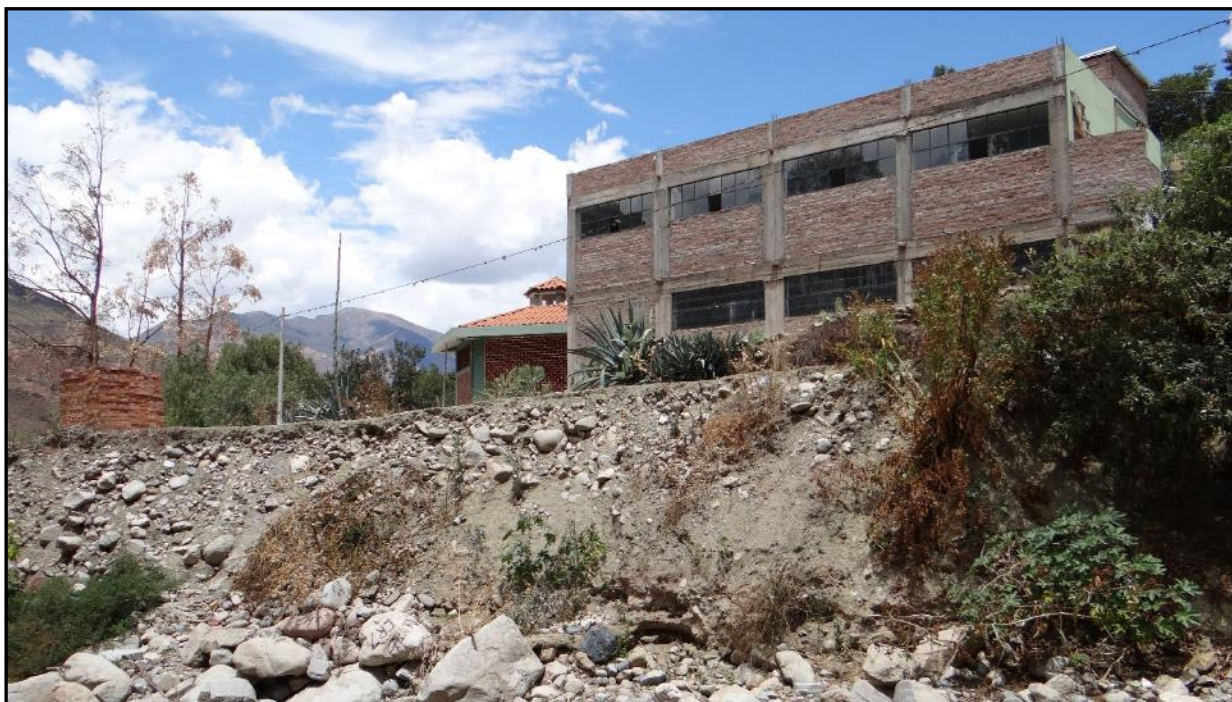
FOTOGRAFÍA Nro. 02: COLEGIO ADYACENTE QUEBRADA ILLAURA
