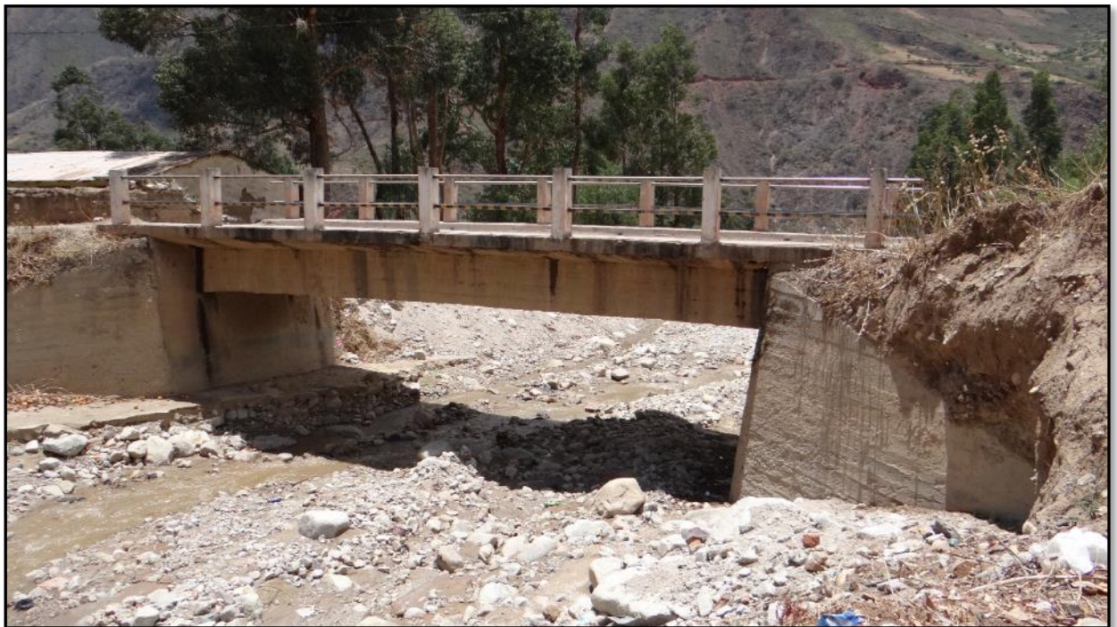
FOTOGRAFÍA Nro. 02: PUENTE SOBRE RIO C HUARMAMAYO
