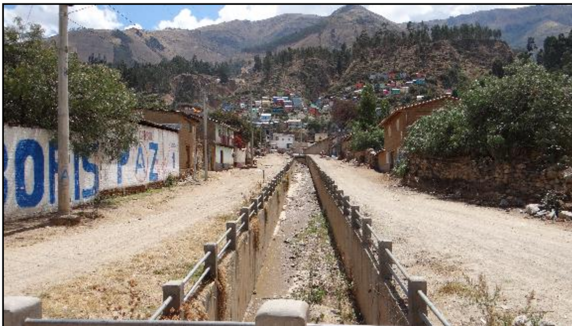
FOTOGRAFÍA Nro. 03 QUEBRADAS CON ENCAUZAMIENTO AL RIO TOROBAMBA
