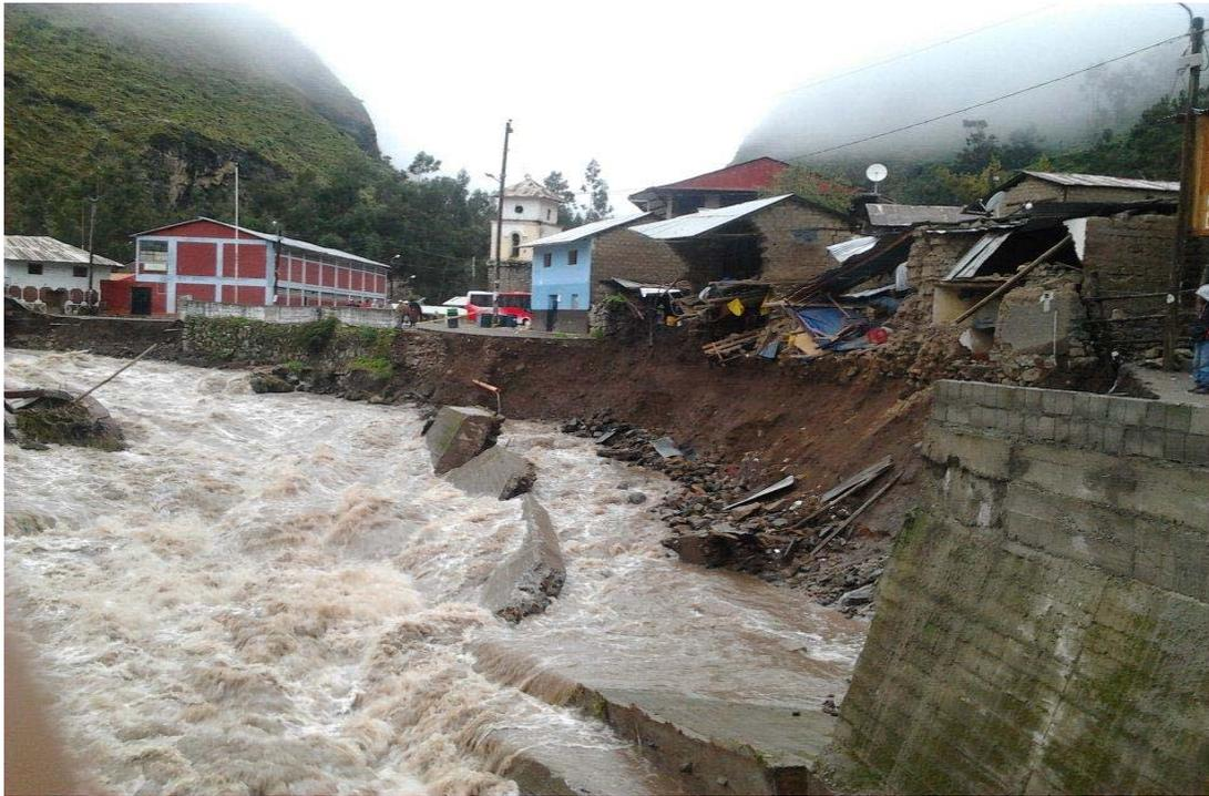
**FOTO 03:** Desborde del río Huantan y erosión de riberas a consecuencia de Máximas avenidas por precipitaciones anómalas en el año 2012.
