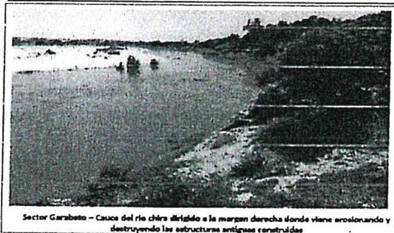
Sector Garabato - Cauce del río chira dirigido a la margen derecha donde viene erosionando y destruyendo las estructuras antiguas construidas.
