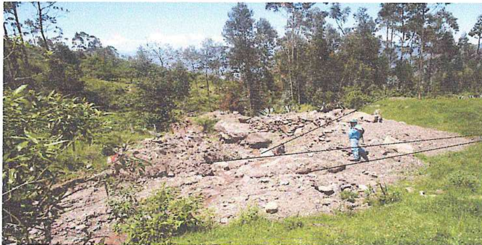
VERIFICACION TECNICA DE CAMPO A LA QUEBRADA DUENDEHUAYCO PUDIENDO OBSERVAR MATERIAL ARRASTRADO POR EFECTO DE LAS LLUVIAS
