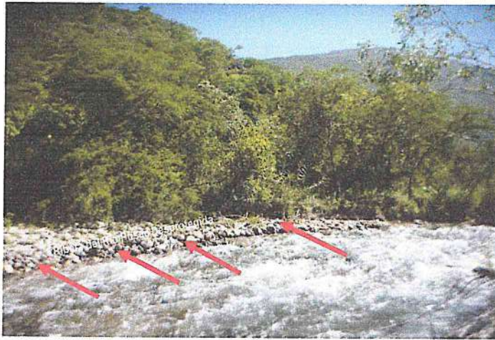
FOTO 1. EN LA IMAGEN SE OBSERVA UN TRAMO CRÍTICO DE LA RIBERA DE LA MARGEN IZQUIERDA DEL RÍO PUSAC TOTALMENTE DESPROTEGIDO, QUE ANTE UNA FUERTE AVENIDA INUNDARÍA CAMPOS DE CULTIVO, INFRAESTRUCTURA VIAL, EDUCATIVA, ETC; POR ESO ES NECESARIO INTERVENIR.
