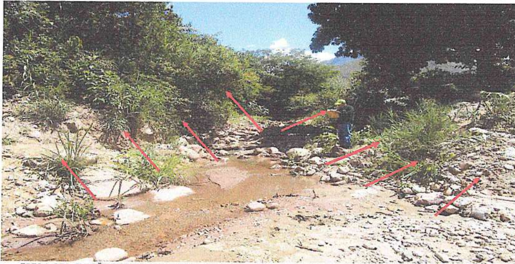
FOTO 1. QDA. CHAGÜIN IDENTIFICADA COMO ZONA CRÍTICA, EN LA IMAGEN SE NOTA CLARAMENTE LA COLMATACIÓN Y EL DEBILITAMIENTO DE LOS TALUDES EN DONDE ES NECESARIO INTERVENIR.
