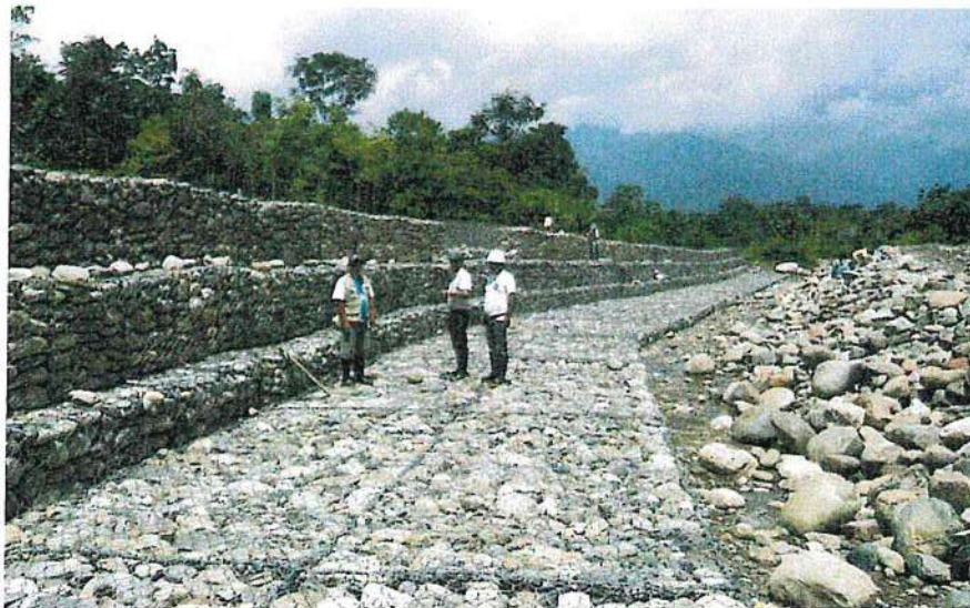
Imagen N° 08: Protección con gaviones
