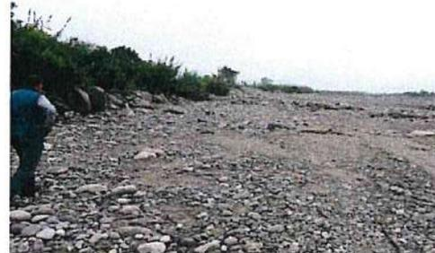
FOTO N°02: VISTA DEL LECHO DEL RIO Y ALGUNAS ROCAS COLOCADAS PARA PALIAR TRANSITORIAMENTE LOS EFECTOS DE EROSION
