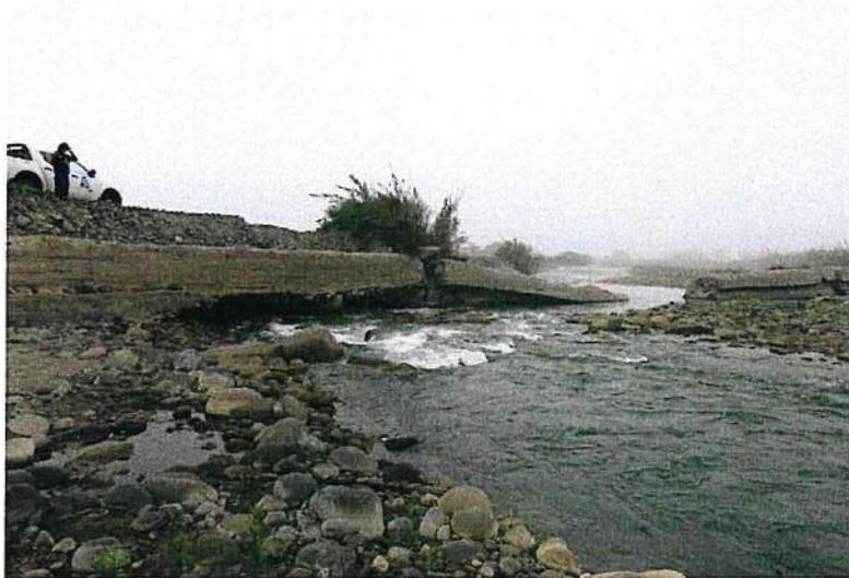
Foto N°3: VISTA DE ESTA ESTRUCTURA QUE COLAPSO POR EROSIÓN DE SU CIMIENTO
