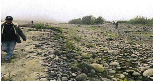
FOTO N°03: VISTA DE LA MARGEN DONDE EL NIVEL DEL CAUCE CON EL TERRENO ES SÓLO DE UNOS 50CM Y EN EL CENTRO DEL CAUCE EN VARIOS TRAMOS ES MAS ALTO QUE EL TERRENO
