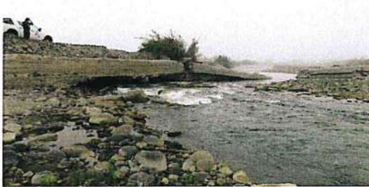
FOTO N°01: VISTA DE ESTA ESTRUCTURA QUE COLAPSO POR EROSIÓN DE SU CIMIENTO
