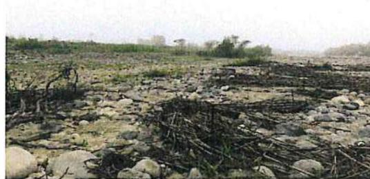
FOTO N°02: VISTA DE EMPALIZADAS EN EL LECHO DEL CAUCE Y MATERIAL COLMATADO EN EL EJE DEL CAUCE QUE SE ENCUENTRAN A NIVEL DE COLINDANCIA DE TERRENOS
