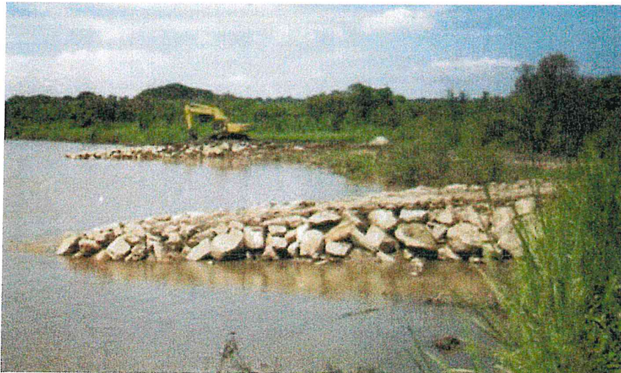
Imagen N° 11: Protección con mampostería de piedra
