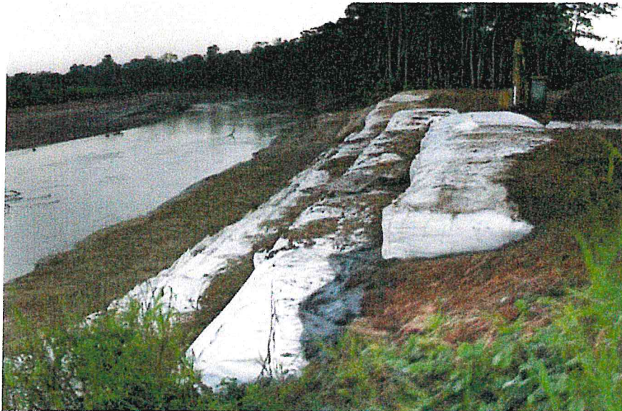
Imagen N° 07: Protección con geobolsas
