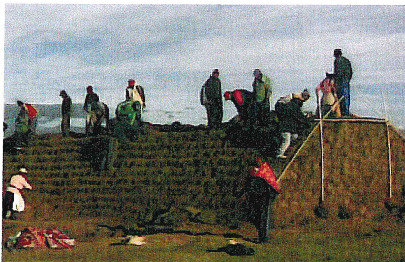
Imagen N° 14: Dique de bloques vegetativo
