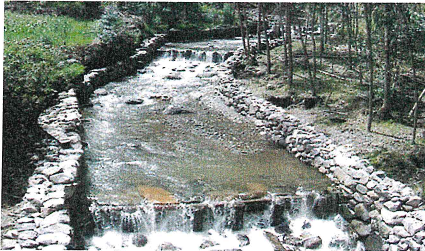
Imagen N° 13: Disipadores de energía en operación ante avenidas
