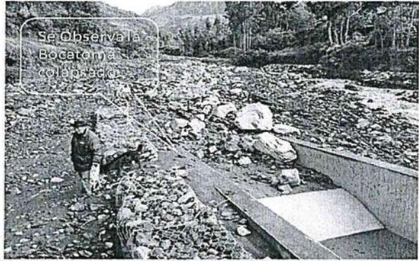
Se Observa Bocatoma colapsada
