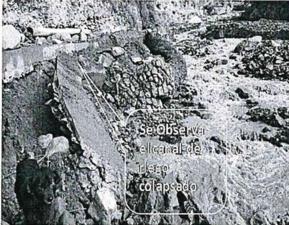
Se Observa el canal de riego colapsado
