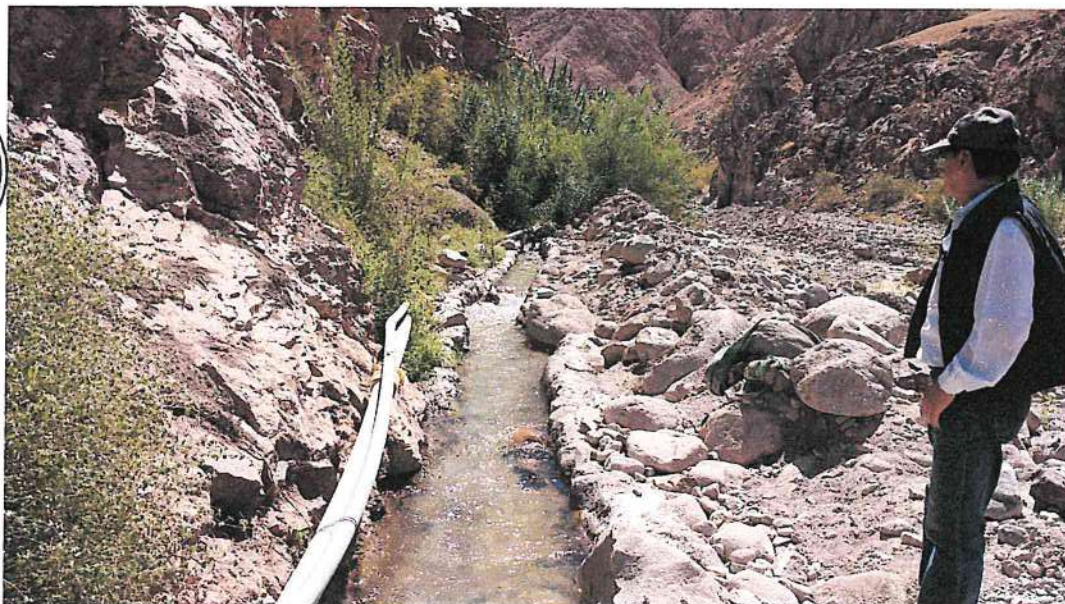
VISTA 2.- CAUCE PRESENTA DESBORDE HACIA LA MARGEN DERECHA, DONDE HA AFECTADO A PREDIOS AGRICOLAS Y EL CANAL HUARACANE.
