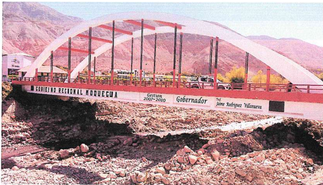
VISTA 3.- CAUCE DEL RIO TUMILACA ALTURA DEL PUENTE TUCUMAN, PRESENTA COLMATACIÓN CON MATERIAL DE ACARREO.
