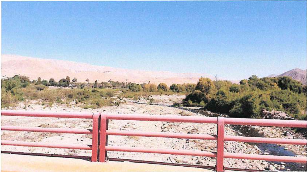
VISTA 4.- CAUCE COLMATADO, PRESENTA COMPORTAMIENTO SERPENTEANTE, QUE PONE EN RIESGO PREDIOS DE CULTIVO EN AMBAS MARGENES, SECTOR EL CONDE.
