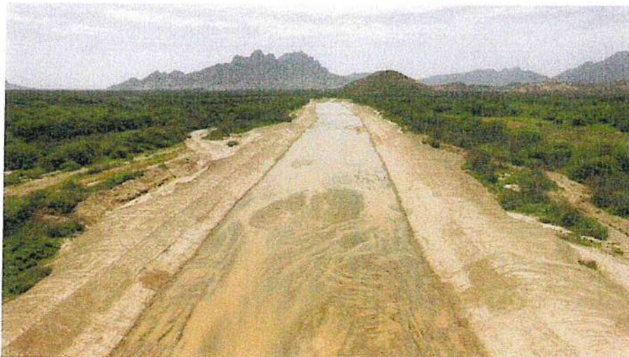
Imagen N° 16: Extracción de material sedimentado de cauce
