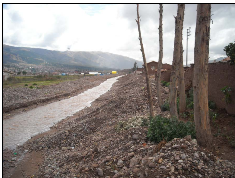
Fig. 8: Río Huatanay colmatado, se observa en ambas márgenes, el material transportado.
