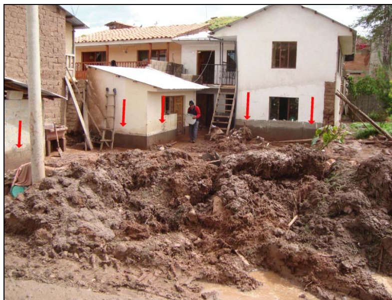
Fig. 7: Fotografía mostrando el nivel de río alcanzado, ver flechas rojas en las paredes de las casas. Fotografía tomada del registro fotográfico de la Municipalidad San Sebastián del Cusco.
