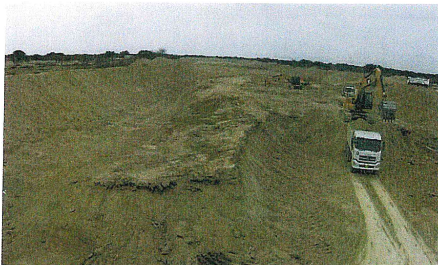
Imagen N° 15: Extracción de material sedimentado de cauce
