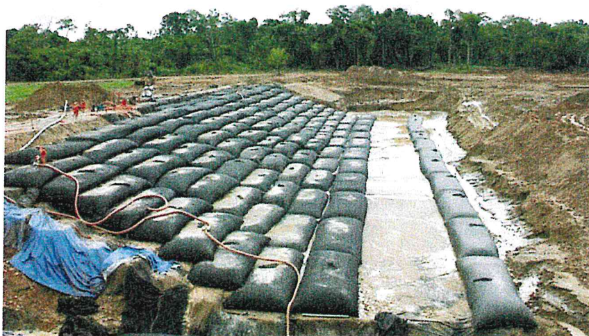
Imagen N° 06: Protección con geobolsas
