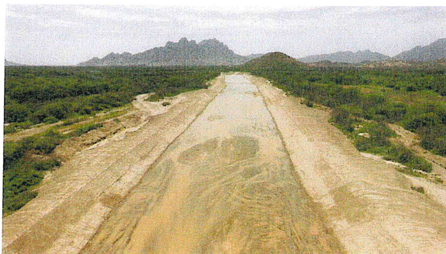
Imagen N° 16: Extracción de material sedimentado de cauce
