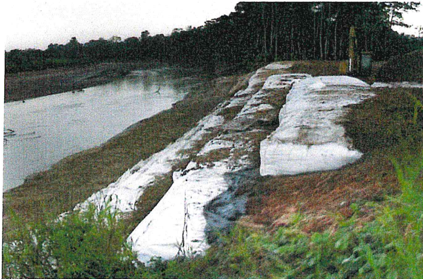
Imagen N° 07: Protección con geobolsas
