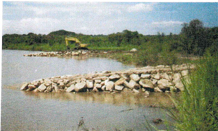
Imagen N° 11: Protección con mampostería de piedra
