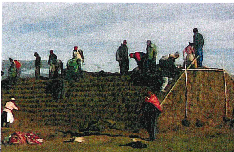
Imagen N° 14: Dique de bloques vegetativo
