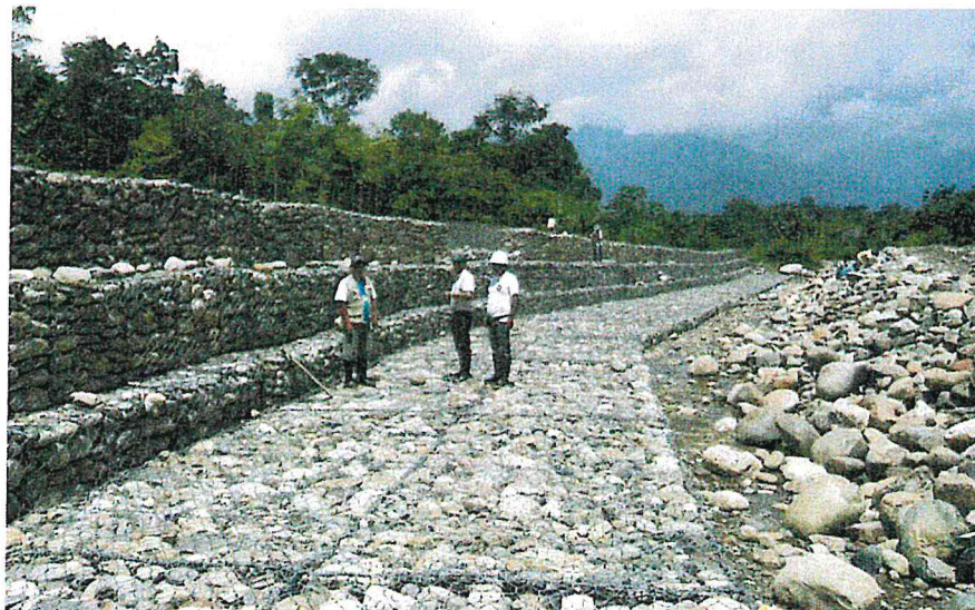
Imagen N° 08: Protección con gaviones
