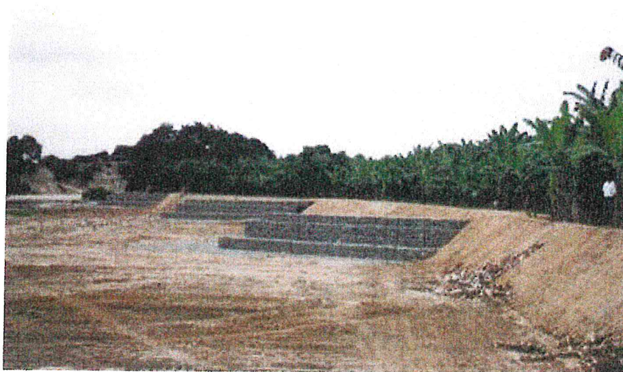
Imagen N° 10: Protección con espigones de gaviones
