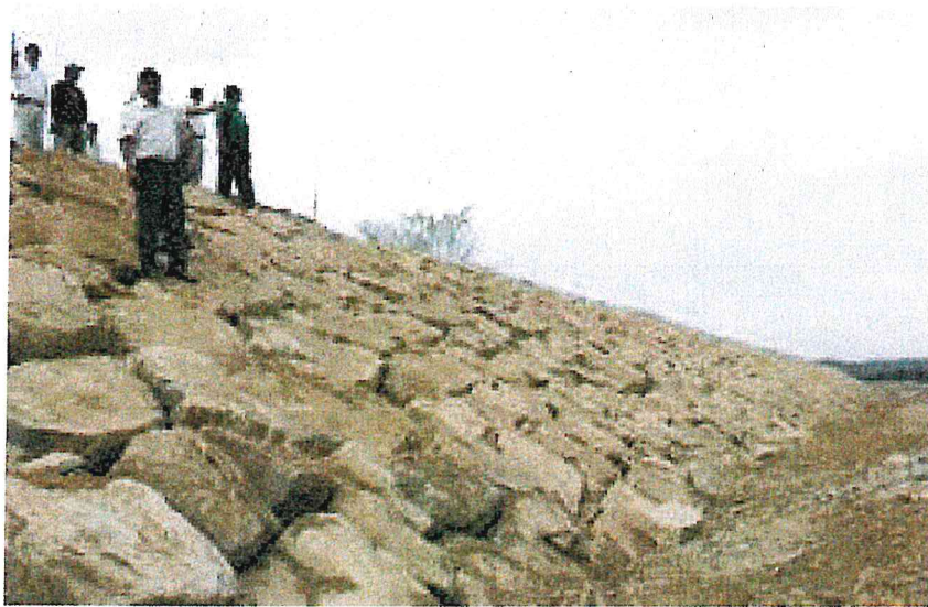
Imagen N° 06: Protección con geobolsas
