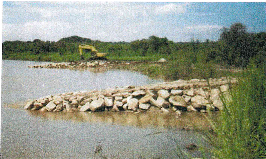
Imagen N° 11: Protección con mampostería de piedra
