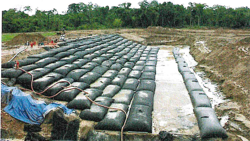
Imagen N° 06: Protección con geobolsas
