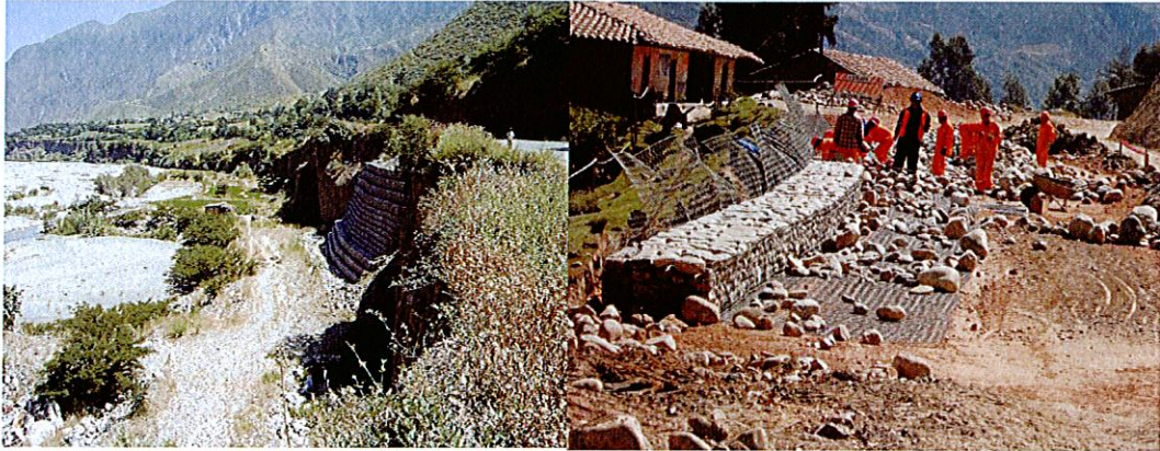
Foto 26: Ejemplo de construcción de muro de gaviones para protección de talud inferior de carretera.
