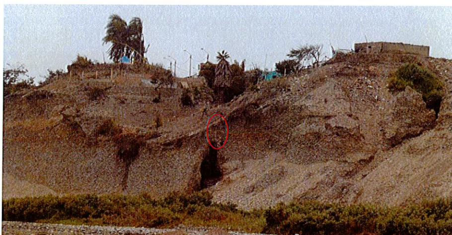
Foto 16: Vista panorámica de los derrumbes en la margen izquierda del río Pativilca, también se generan cárcavas por la presencia de tuberías de desagües que desembocan en el talud, en el sector La Garita (A-002).
