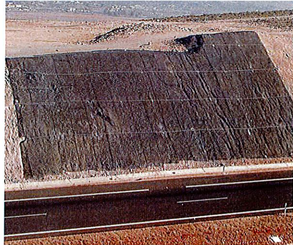
Figura 12: Empleo de mallas metálicas en taludes (adaptada de FHWA, 1988).
