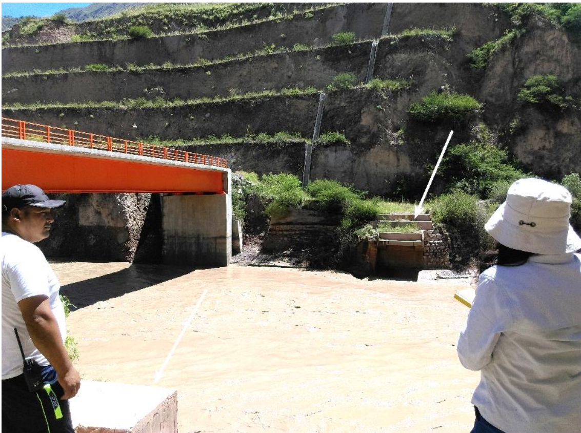
Foto 5. Vista actual del puente Pampas, a 10 metros de estribos del puente antiguo destruido por el represamiento del 2011.
