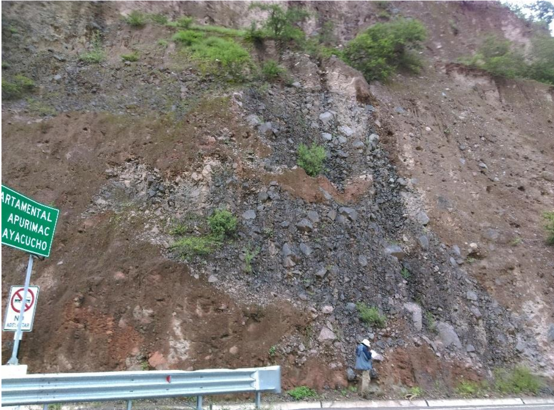
Foto 4. Depósitos aluviales en contacto con depósitos de avalancha en el puente Pampas.
