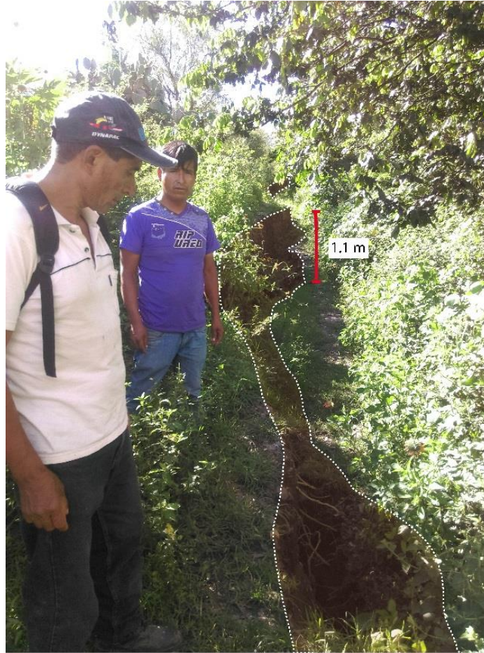
Foto 10. Agrietamientos (línea blanca) a 100 metros de la zona de derrumbes. Los desplazamientos varían de entre 10 cm a 2 m.
