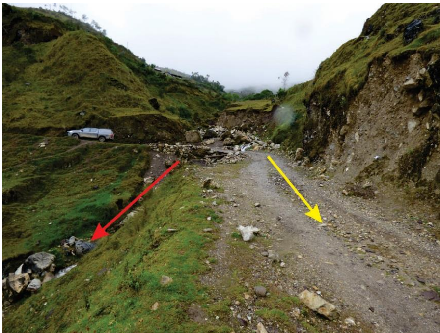
Foto 1. Se señala el paso del flujo de detritos, por su canal natural (línea roja), por la carretera (línea amarilla).
