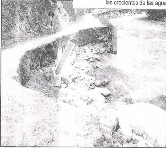
ZONA CRÍTICA N° 08: Margen derecha del río Tulumayo afectado por las crecientes de las aguas (Progresiva 17+230 hasta 17+380).
