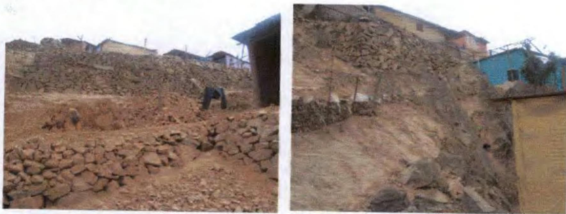
Foto N° 7 y 8. Obsérvese en ambas fotos las pircas de variado tamaño y sin ningún tipo de amalgamación
