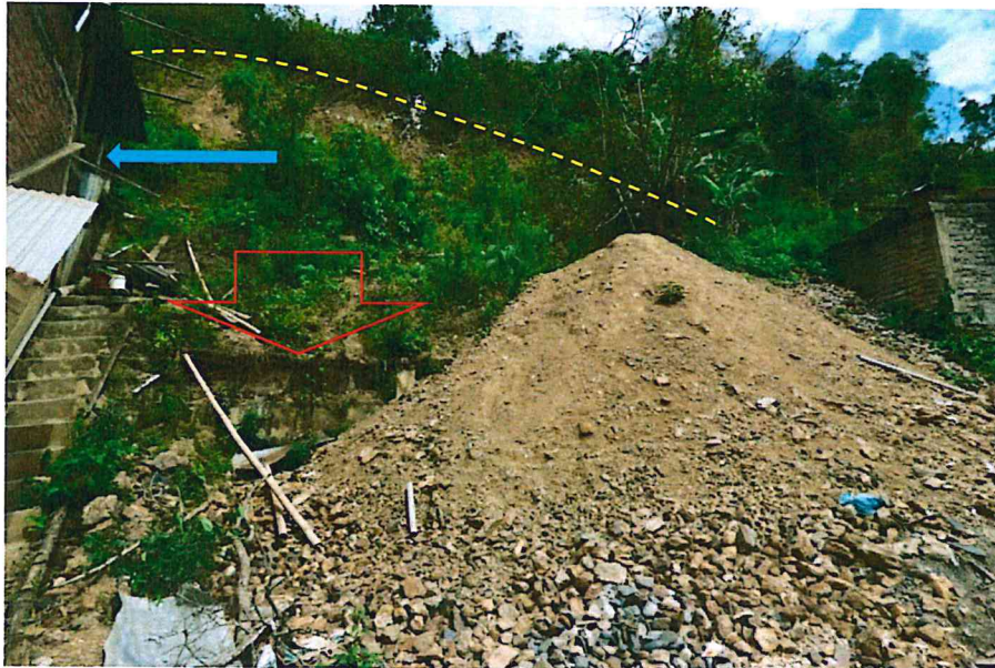
Foto 10. En líneas discontinuas amarillas se delimita escarpa de deslizamiento como parte de la reactivación del deslizamiento antiguo. La flecha roja señala parte del muro de vivienda afectada por deslizamiento.
