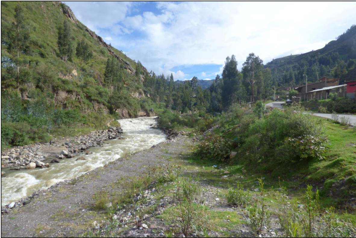
Foto 15: Terrazas de origen fluvial a la margen izquierda del río Acochaca, susceptibles a inundaciones.
