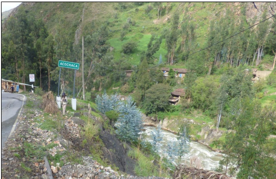
Foto 14: Margen derecha del río Acochaca sin protección ribereña.
