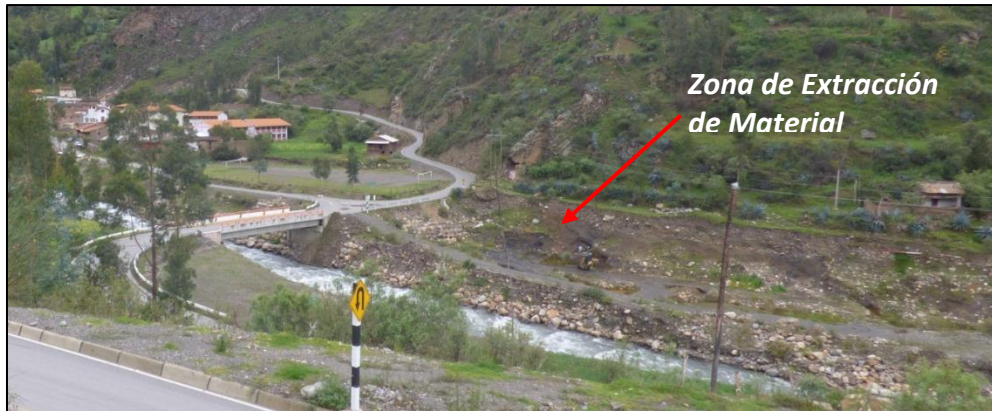
Foto 13: Terrazas de origen fluvial a la margen izquierda del río Acochaca, susceptibles a inundaciones.
