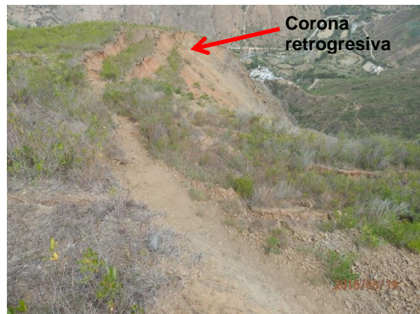
Foto 2. Parte superior del deslizamiento
