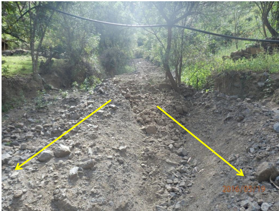
Foto 5 Vista de la quebrada Tararagra, donde se observa el material detrítico dejado por el flujo ocurrido en el año 2014
