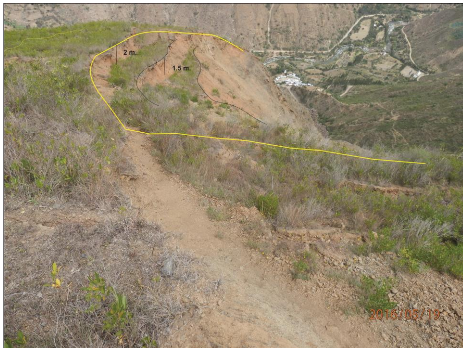
Foto 3. Vista tomada con dirección este, se observa la escarpa principal de la zona deslizada.
