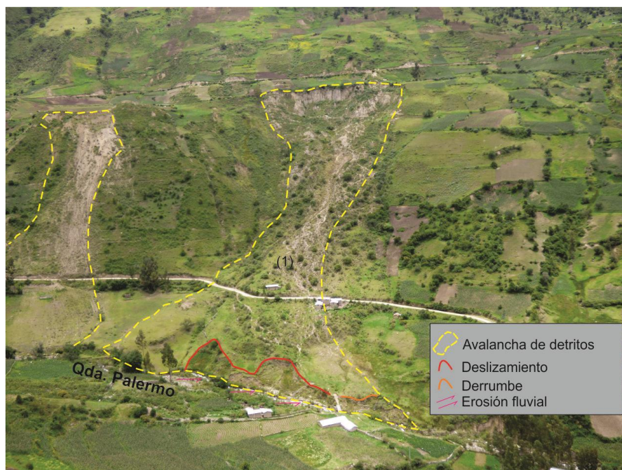
Foto 8. Se aprecia dos avalanchas de detritos. (1). Evento que destruyó 06 viviendas y donde murieron 11 personas.
